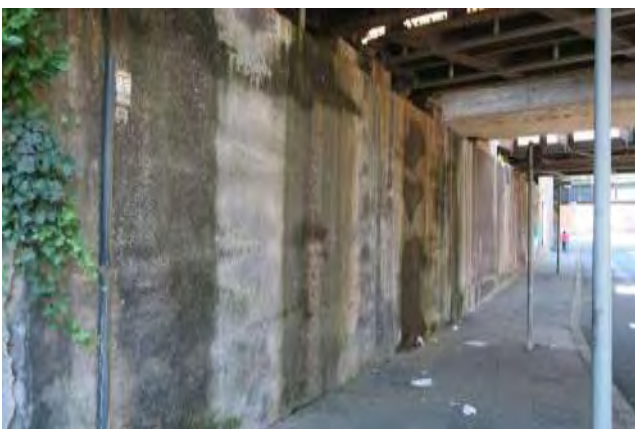
Abbildung 59: Unterführung Marktstraße/ Alleestraße
