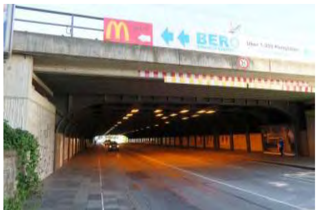
Abbildung 58: Unterführung Buschhausener Straße
