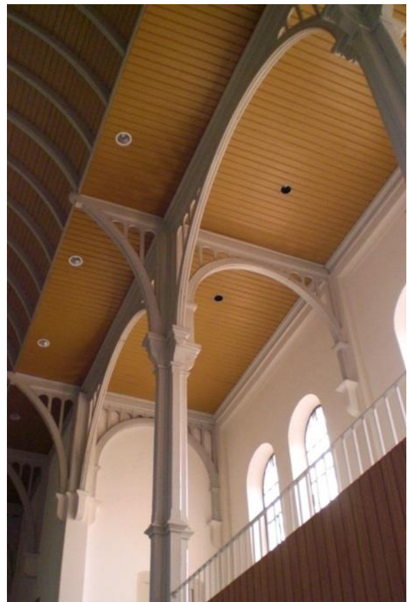
Innenansicht, Empore mit Holzstützen
