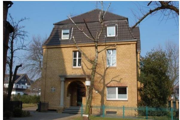
Blick auf die Südwestfassade des Pfarrhauses mit dem Portaleingang zum ehem. Pfarrbüro (Kirchvorplatz)-
