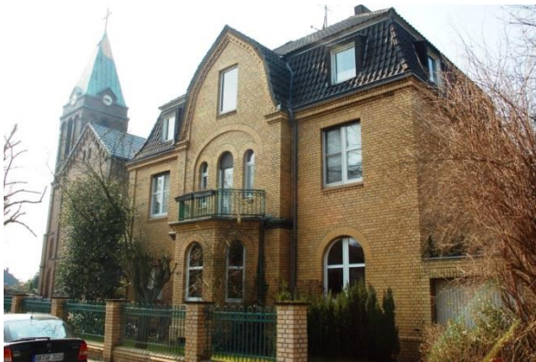
Blick auf die Südwestfassade des Pfarrhauses mit der Einfriedung (Kempkenstraße) (Fotos: Stadt Oberhausen, 2013)
