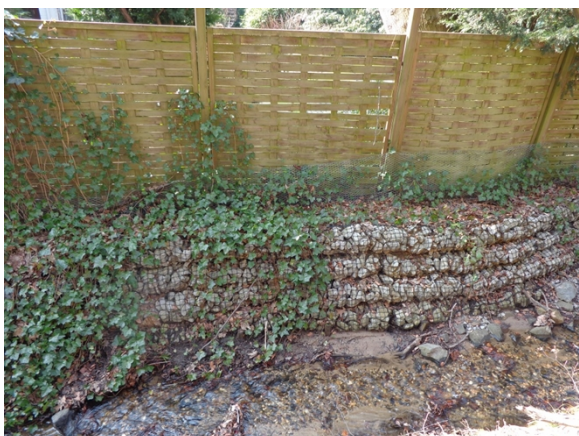
110 111 Uferbefestigung mit Steinen
