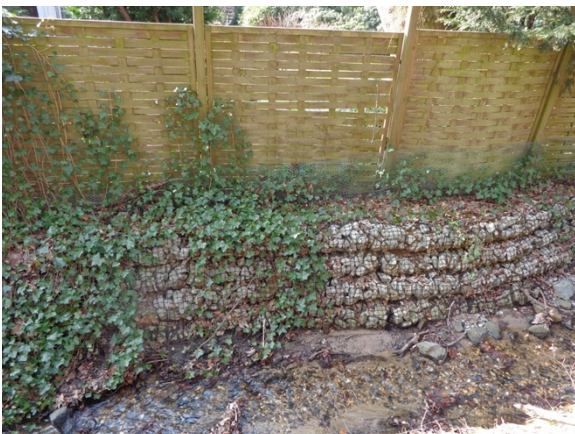
110 111 Uferbefestigung mit Steinen
