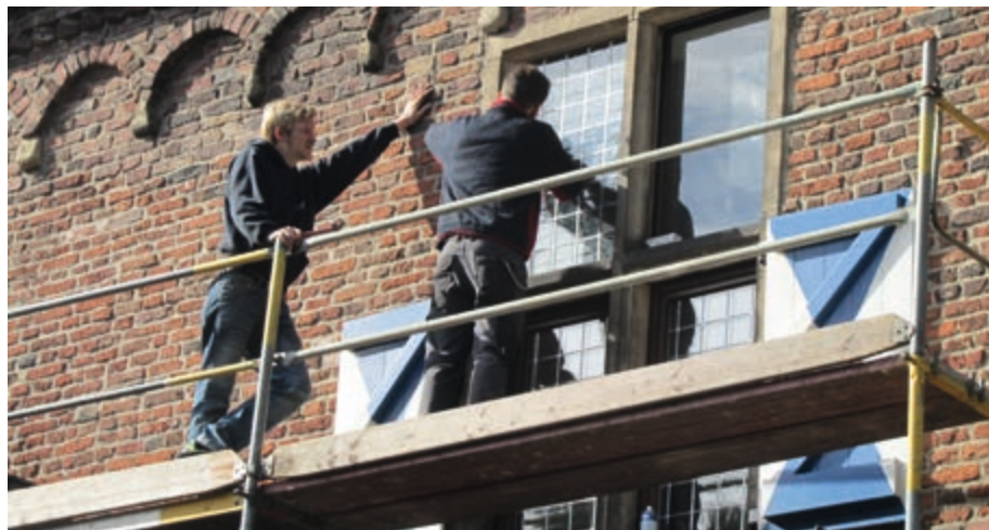
Die Fenstersanierung in der Vorburg ist abgeschlossen
