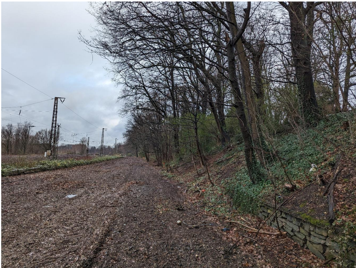
Abbildung 4: Blickrichtung Norden (Bahn-km 5,0 Bahnrechts)
