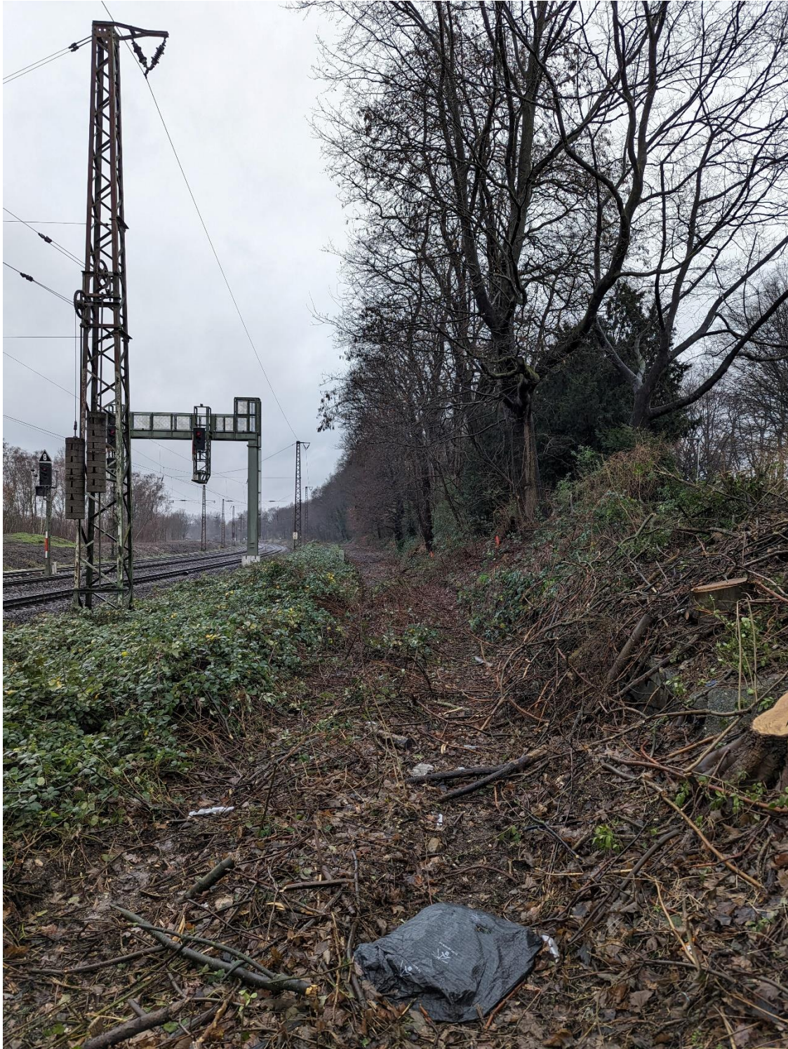
Abbildung 2: Blickrichtung Norden (Bahn-km 4,7 Bahnrechts)
