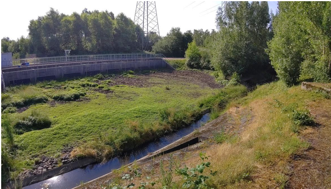
Foto 6: Blick auf das Rückhaltebecken und den Läppkes Mühlenbach am östlichen Ende der geplanten Zuwegung.
