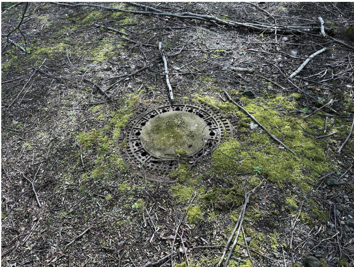
Foto 7: Schachtzugang des bestehenden Regenwasserkanals unter dem geplanten Unterhaltungsweg.
