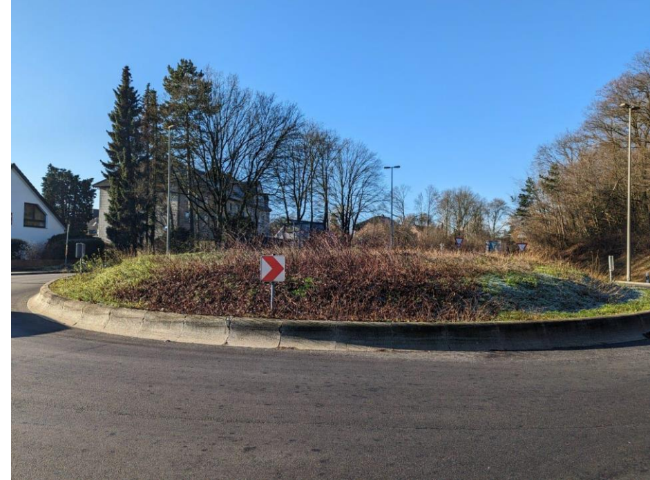
Hünenbergstraße / Anschlussstelle A3 Dinslaken Süd (Straßen-NRW)
