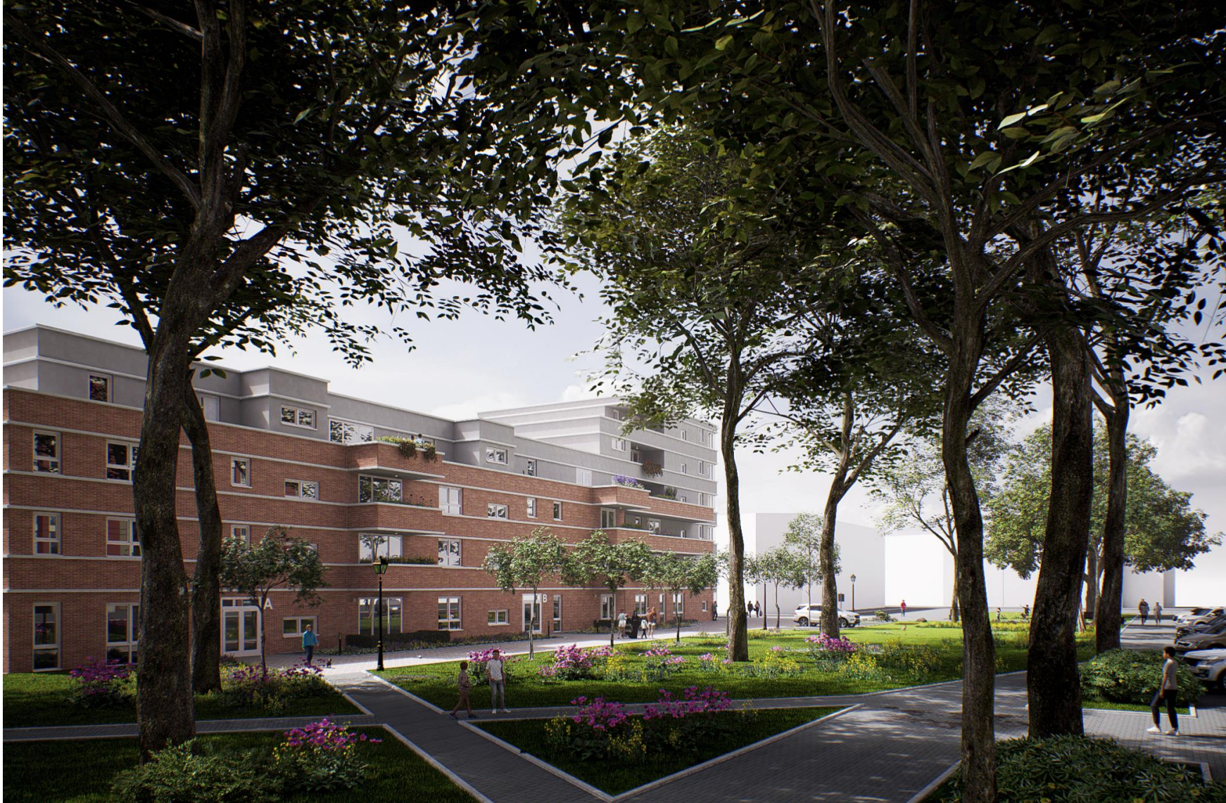
Ansicht aus Nord-Ost
