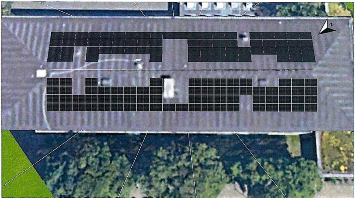
Abbildung: 1. Modulfläche - Gebäude 01-Dachfläche Nordwest
