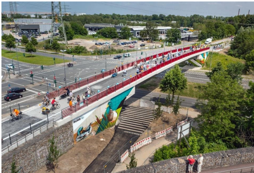
Abb. 21 Brücke RS 1 in Essen (Neue Brücke über Berthold-Beitz-Boulevard in Essen; Regionalverband Ruhr)
