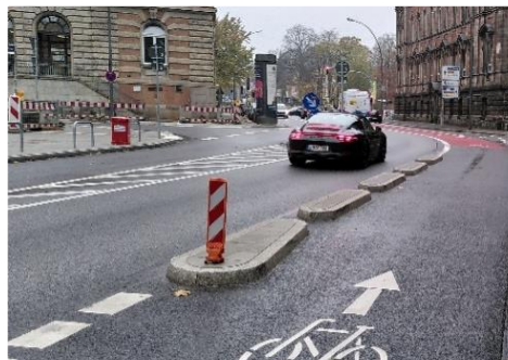
Aus- und Umbau der Infrastruktur
