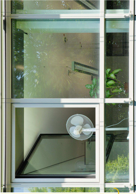
Abb. 22 In den intensiveren und längeren sommerlichen Hitzeperioden ist es zunehmend eine Herausforderung, ein nutzerfreundliches Innenraumklima zu erhalten. In Zukunft wird voraussichtlich die Notwendigkeit der sommerlichen Kühlung von Innenräumen in öffentlichen Gebäuden zunehmen.
