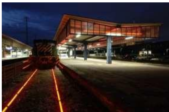
Abb. 3: Der Oberhausener Hauptbahnhof Gleis 4 und 5 als Museumsbahnsteig.
