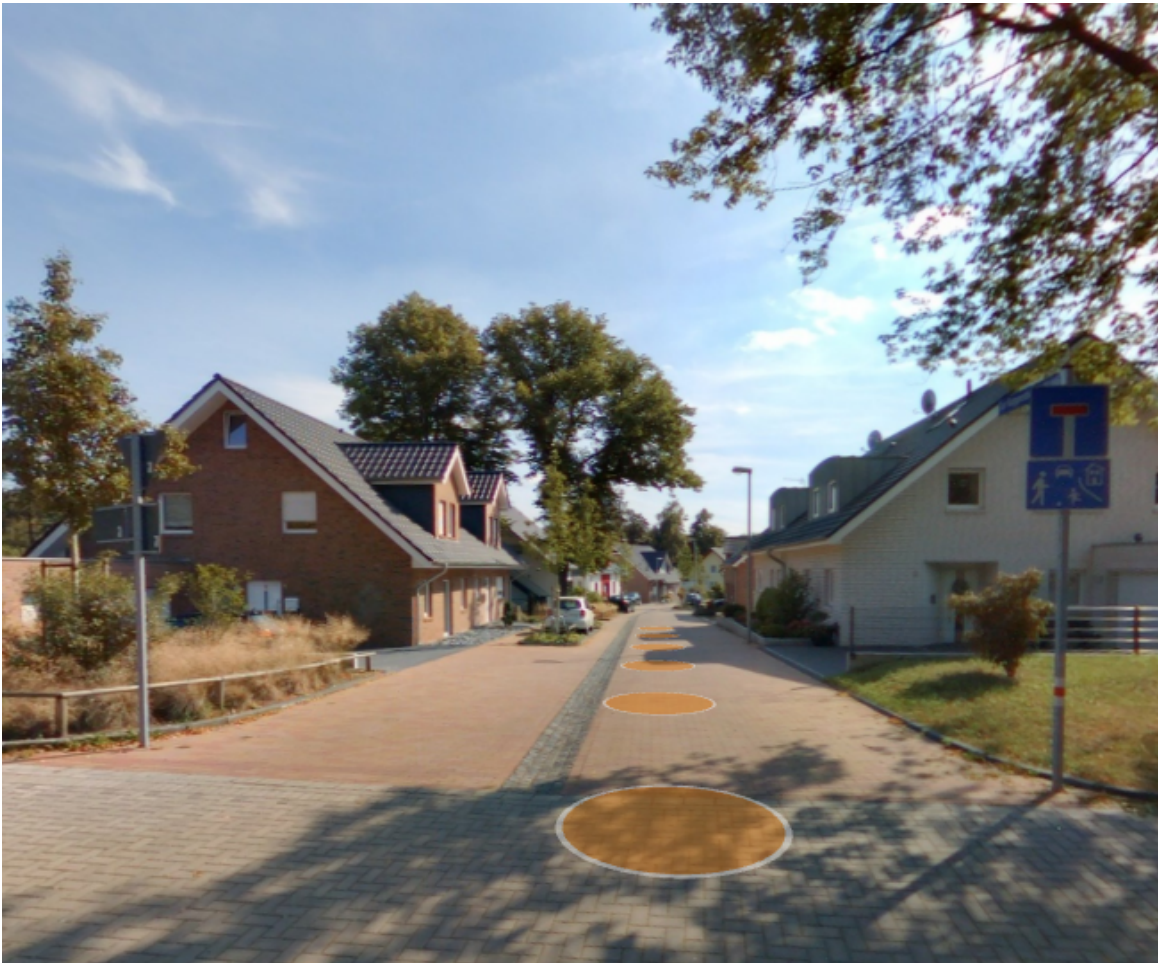
Quelle Streetsmart: Zur Koppenburgs Mühle / Ausbau als Mischverkehrsfläche ohne Separationsprinzip
