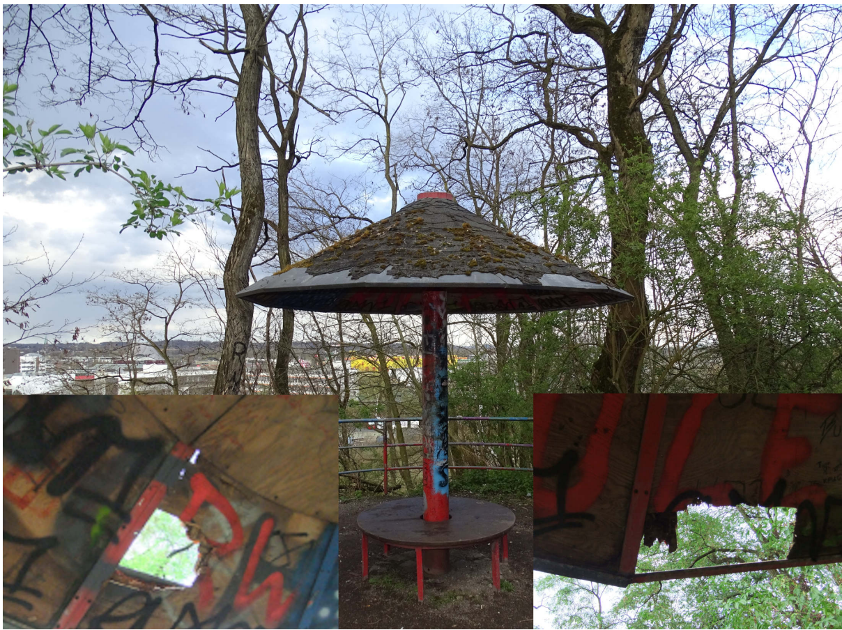
Bild 1: Der Sitzpilz auf der Knappehalde mit eingefügten Detailansichten der Beschädigungen. Im Hintergrund das Sicherungsgeländer.
