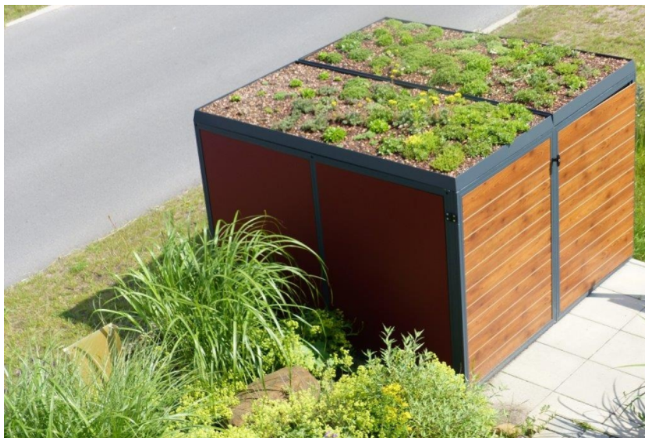
Abbildung 4: Exemplarische Dachbegrünung der Anlagen (Quelle: https://freudengarten.de/ )
