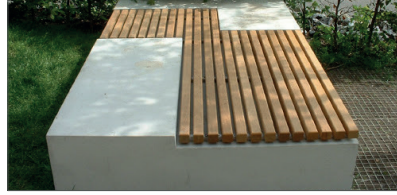
⑦ Betonpodest mit Hartholzauflage
