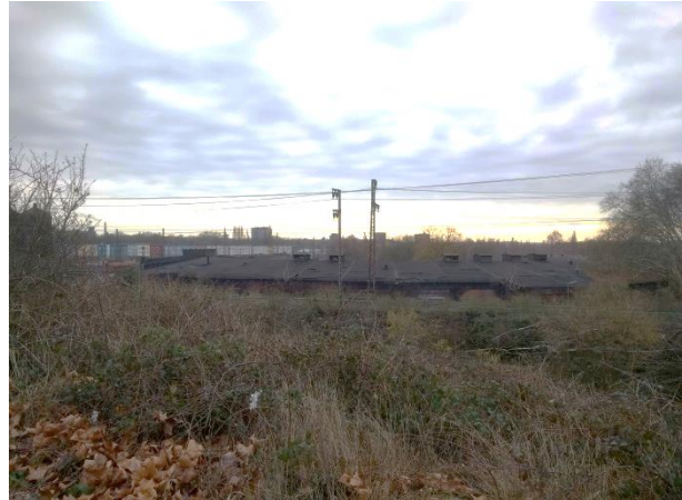
Abbildung 3: Böschung an der Bahnanlage
