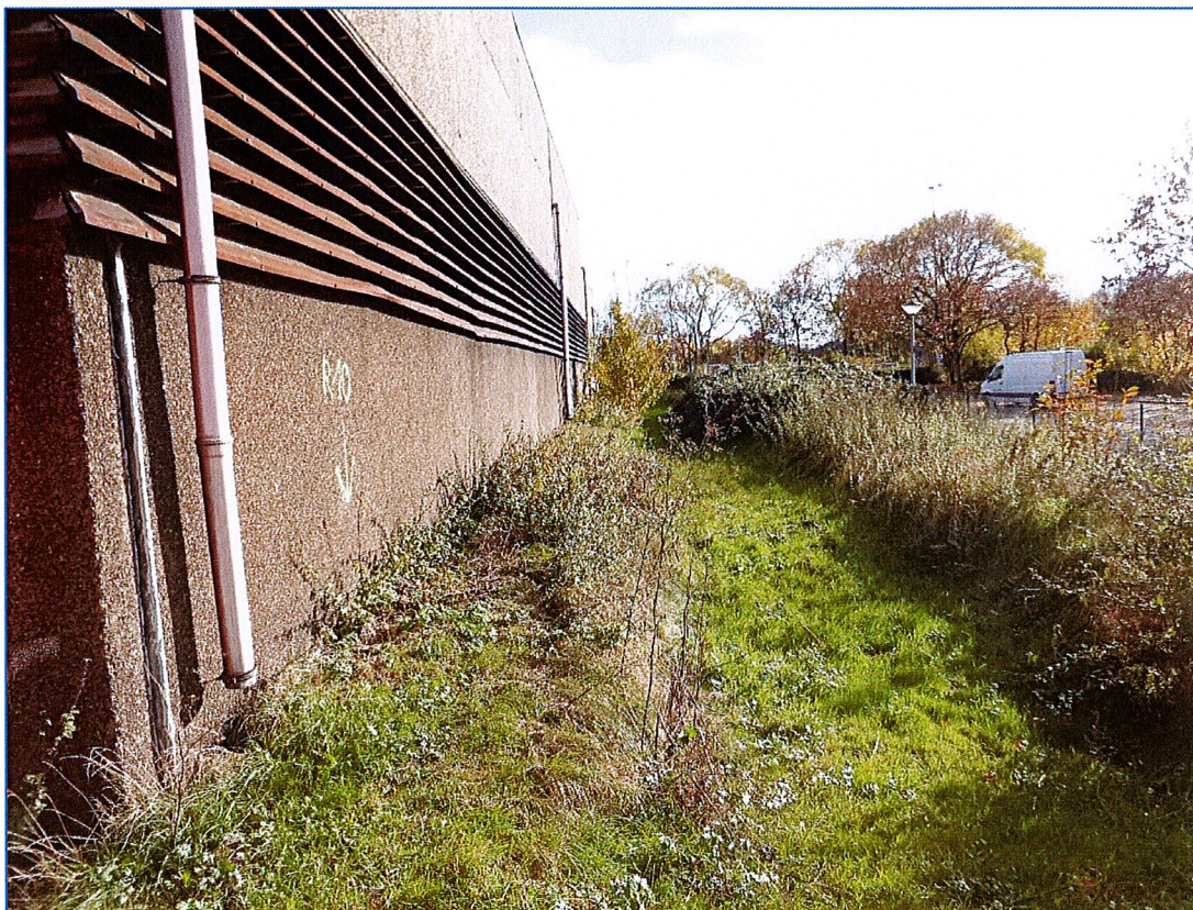
Versickerungsmulde entlang der Dachsstraße
