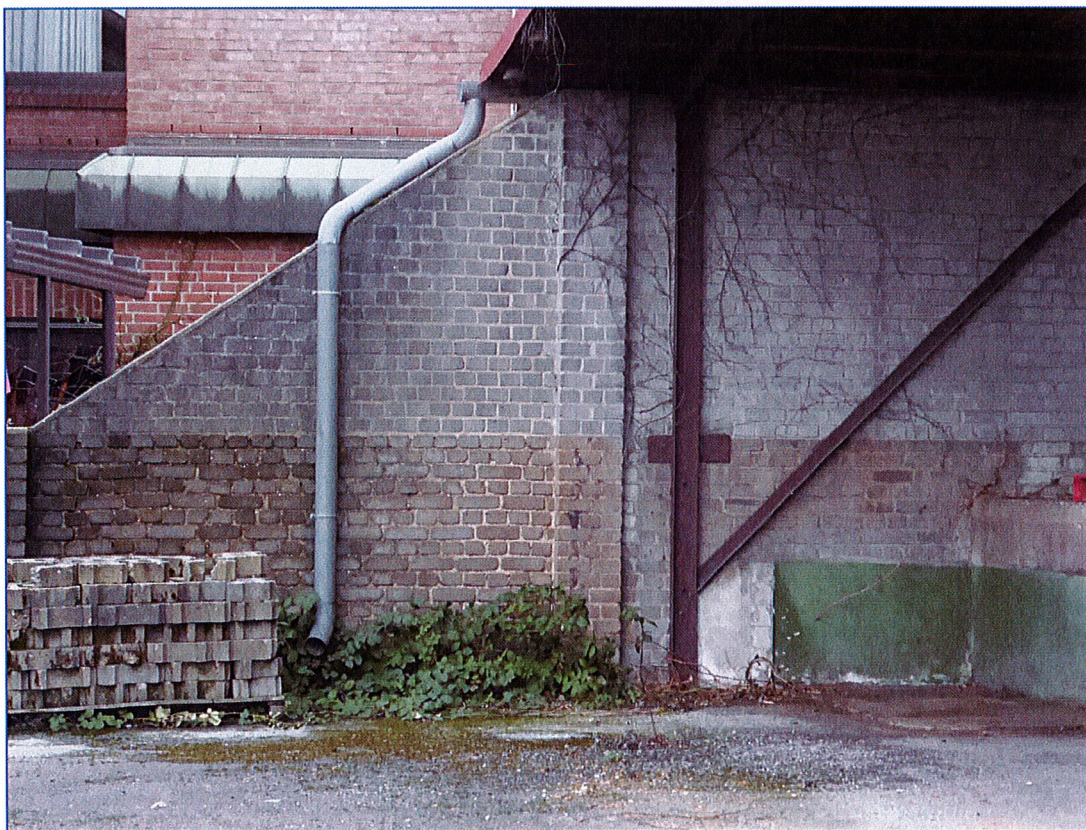
Ehem. Tankwanne (recht) unter Schleppdach
