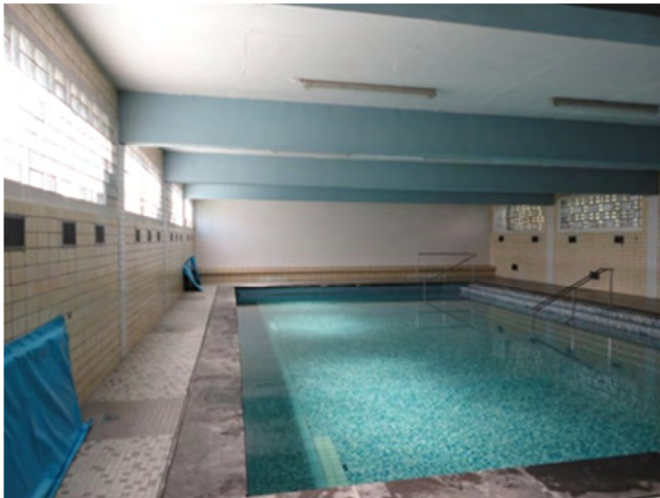
Foto Nr. 1 Lehrschwimmbad mit Glasbausteinen
