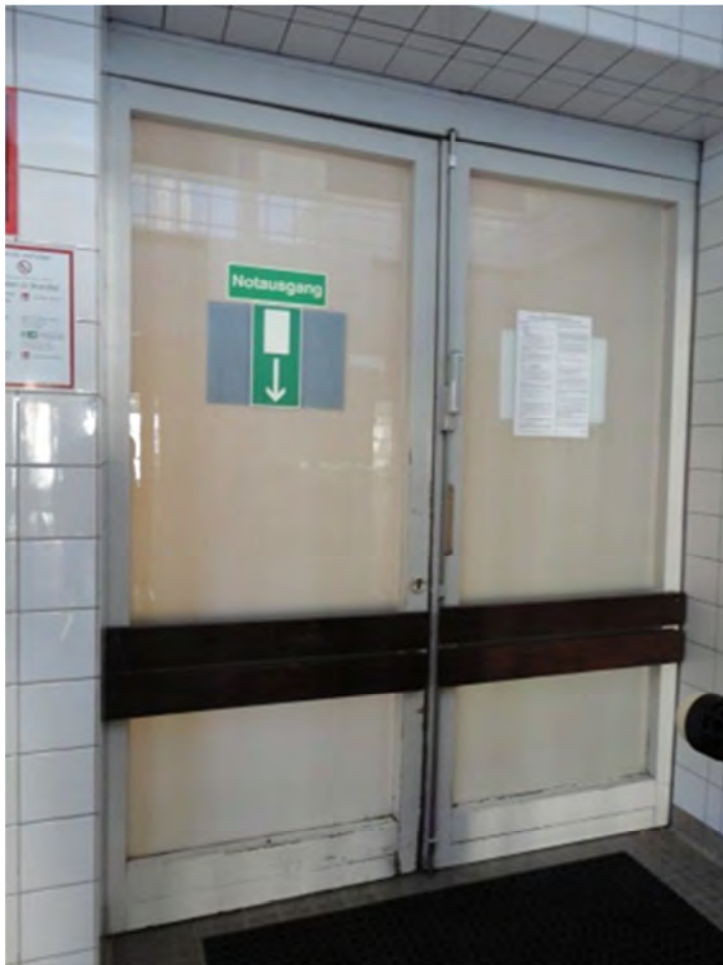
Foto Nr. 3 Einfachverglaste Außentür eines Lehrschwimmbads
