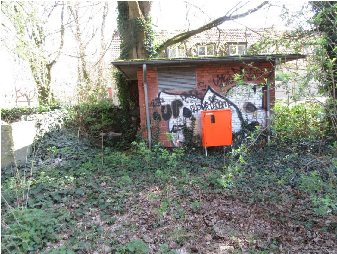
Ein kleines Gebäude der Energieversorgungsbetriebe Oberhausen steht im östlichen Randbereich.
