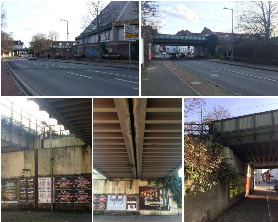
Abbildung 27: Impressionen Unterführung Ecke Rheinische Straße/ Vestische Straße
