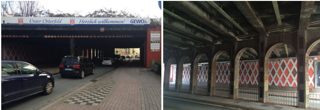
Abbildung 28: Impressionen Unterführung Ecke Rheinische Straße/ Bergstraße
