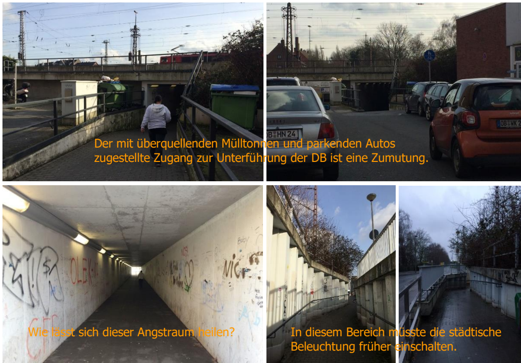
Abbildung 30: Impressionen Fußgängerunterführung Waghalsstraße
