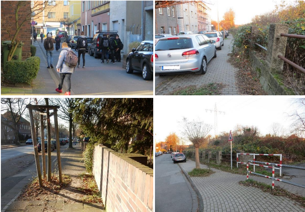
Abbildung 15: Mangelhafte Gehweggestaltung (links oben: Henselstraße; rechts oben: Welsche Straße; links unten: Kapellenstraße; rechts unten: Kampstraße)
