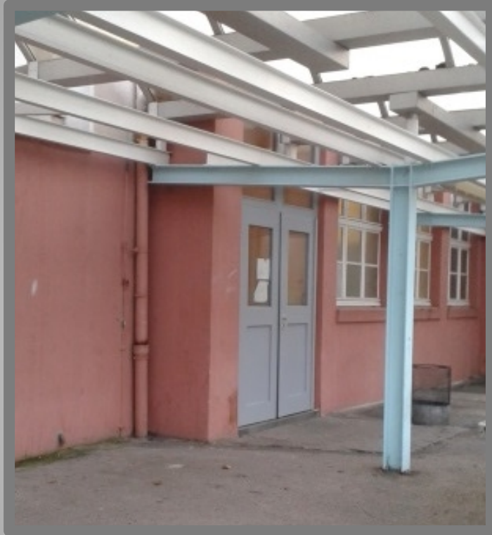
Zukünftiger Eingang ehem. Hauptschule Lirich
