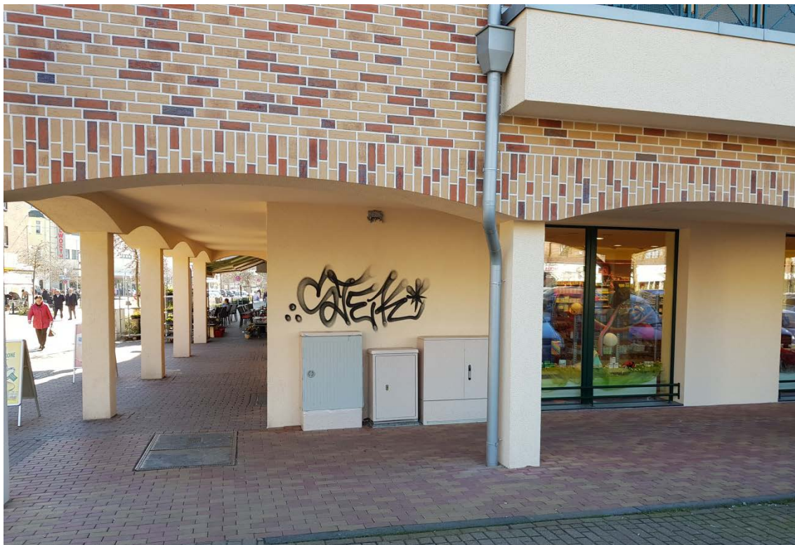
- Fassade Gildenstraße Ecke Marktplatz Osterfeld-
