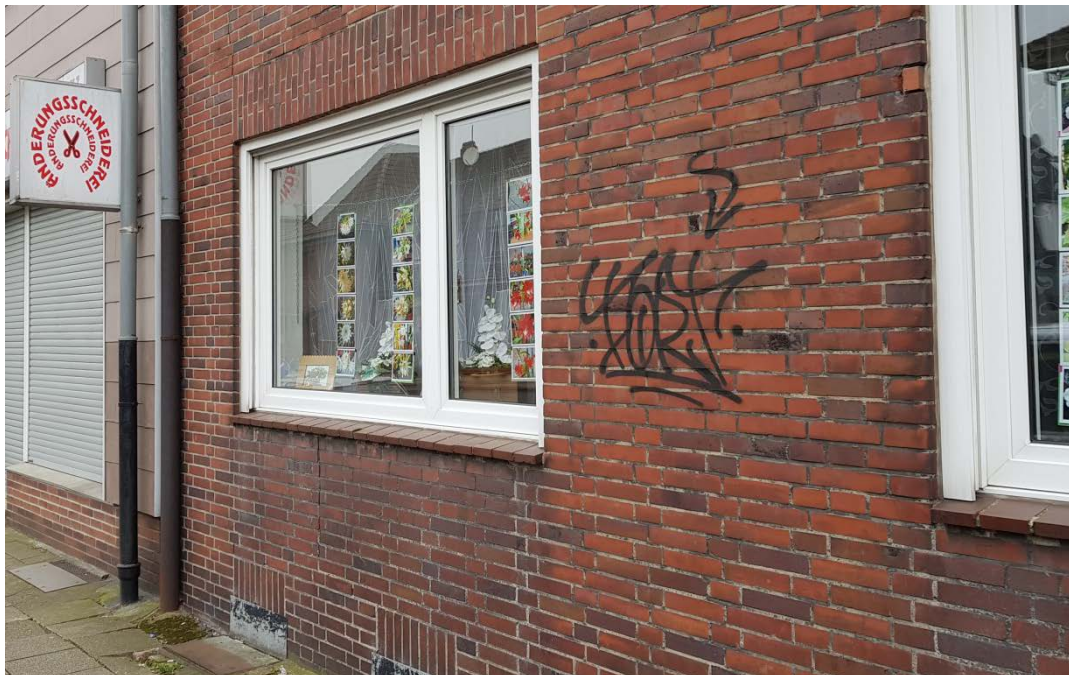
- Fassade Teutoburger Straße 256 -
