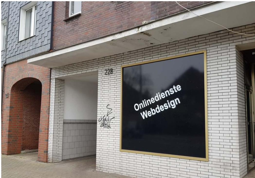
- Fassade Teutoburger Straße 228 -
