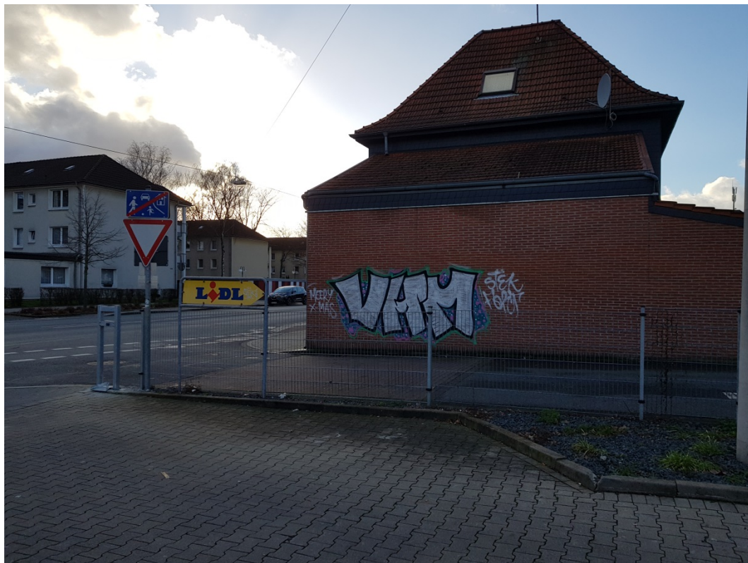
- Fassade Teutoburger Straße 311 Ecke Turnplatzstraße -
