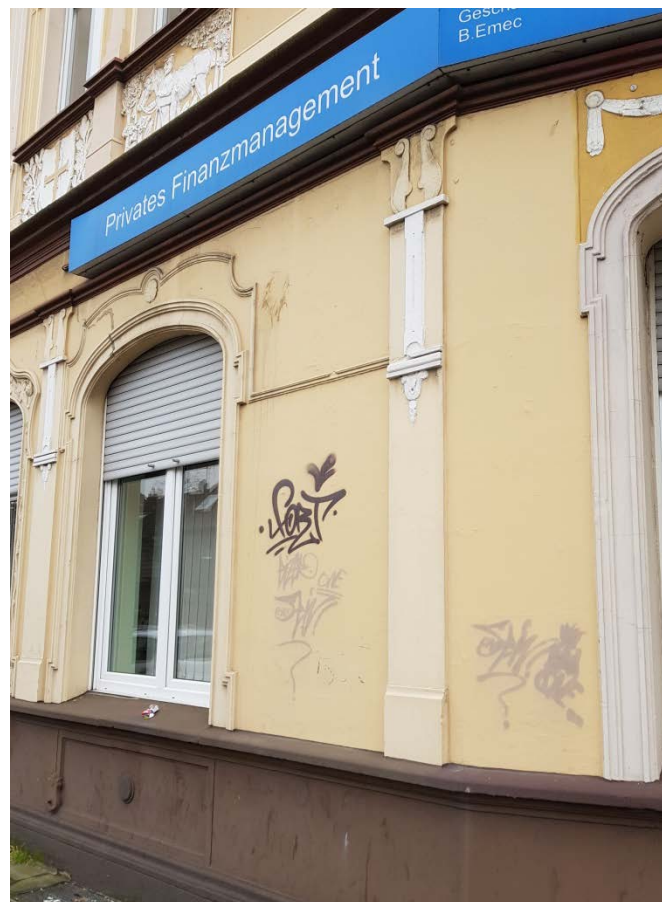
- Fassade Teutoburger Straße 222 -
