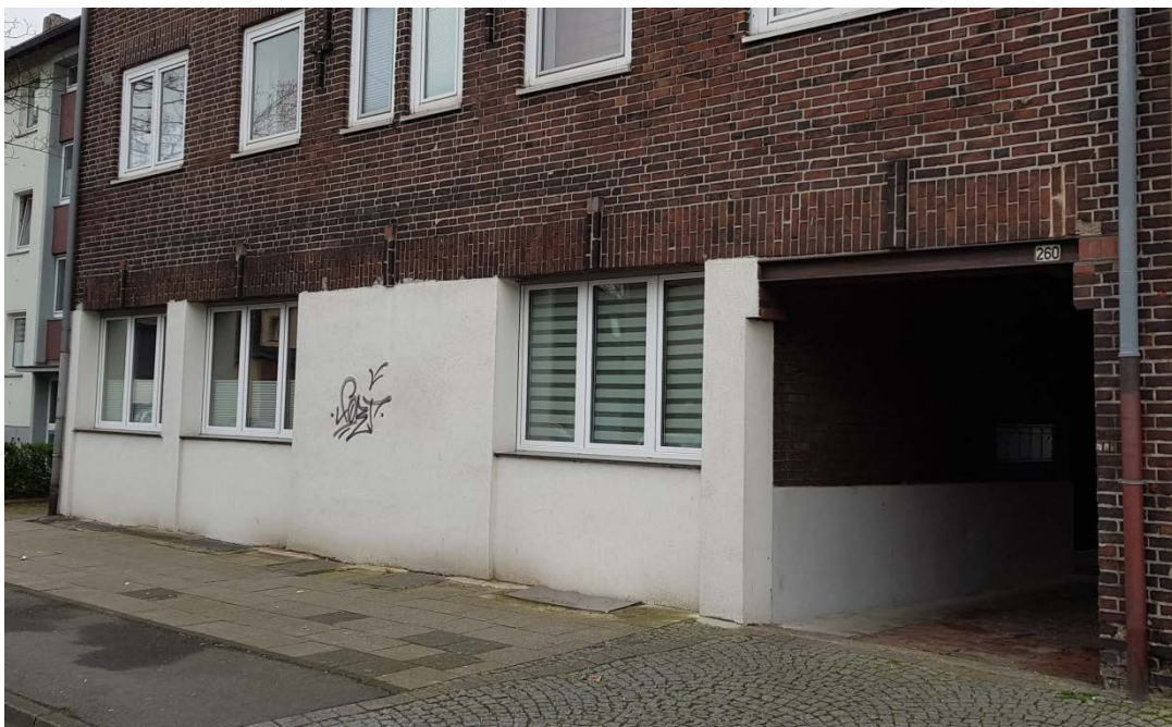
- Fassade Teutoburger Straße 260 -
