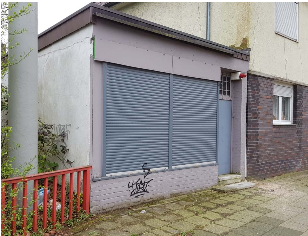
- Fassade Teutoburger Straße 216 -
