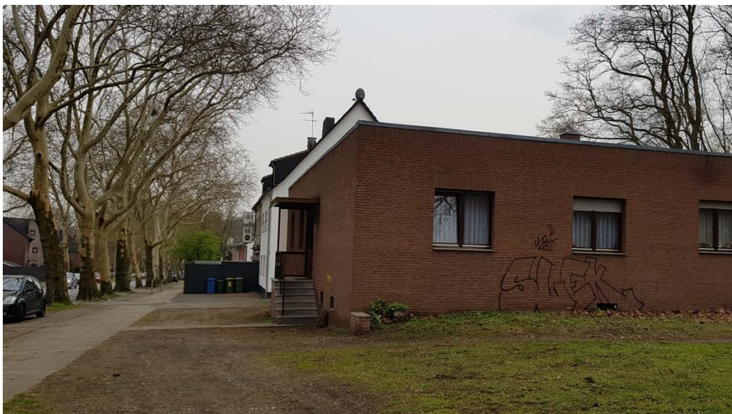
- Fassade Kapellenstraße 127 Ecke Teutoburger Straße -
