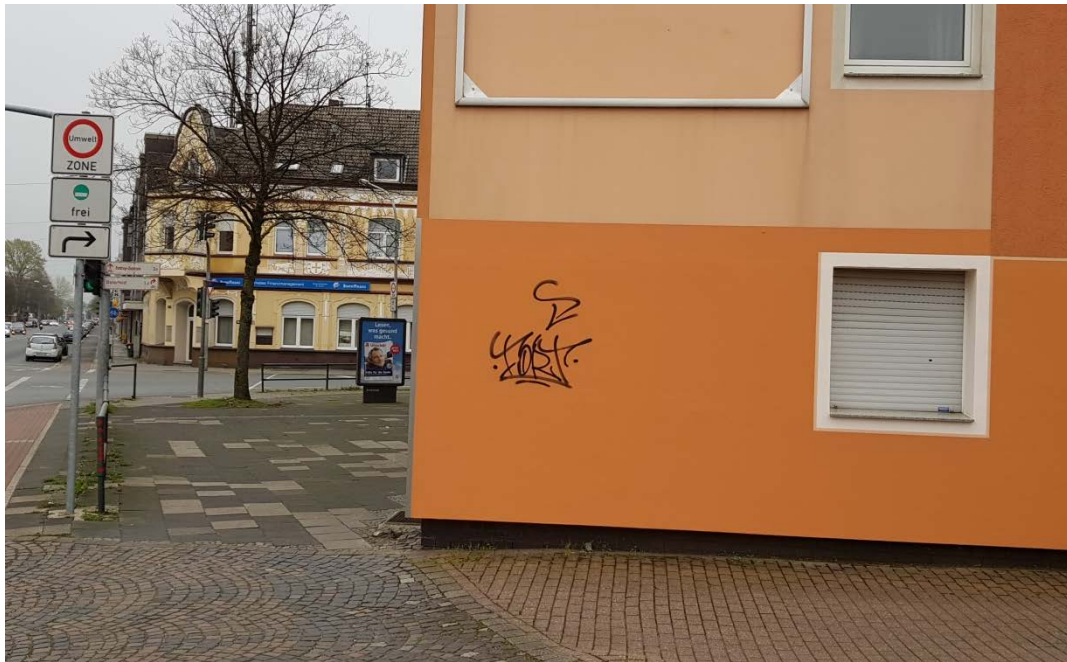
- Fassade Teutoburger Straße 220 -
