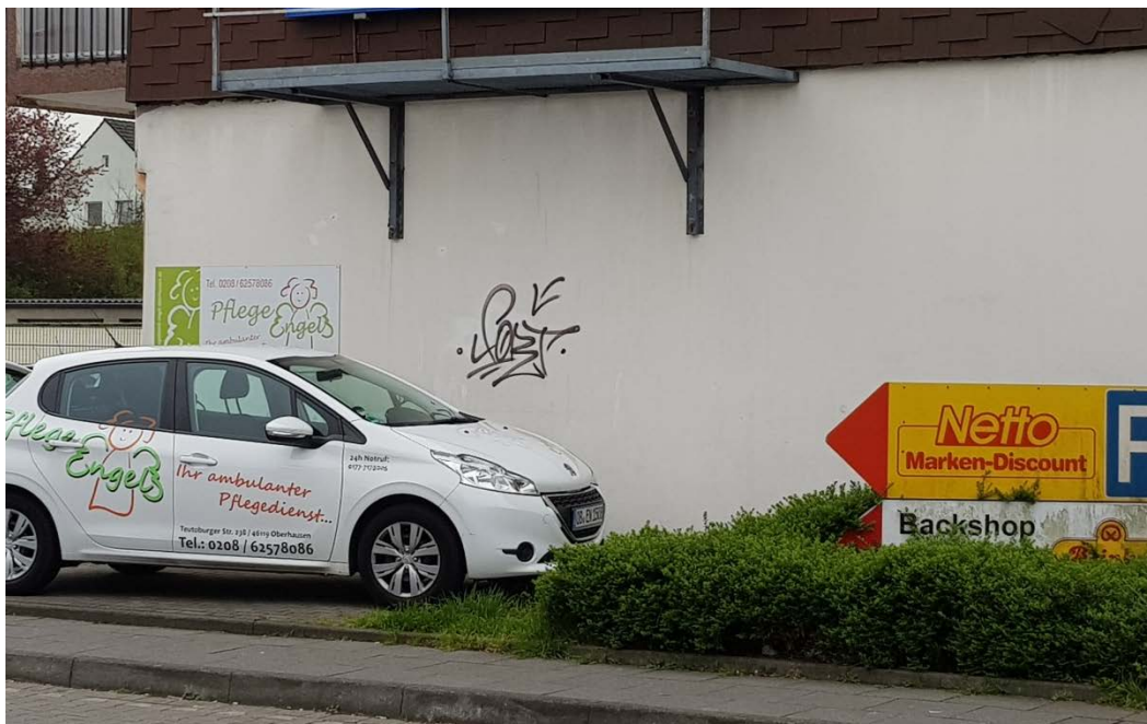
- Fassade Teutoburger Straße 238 Zufahrt Netto Parkplatz -
