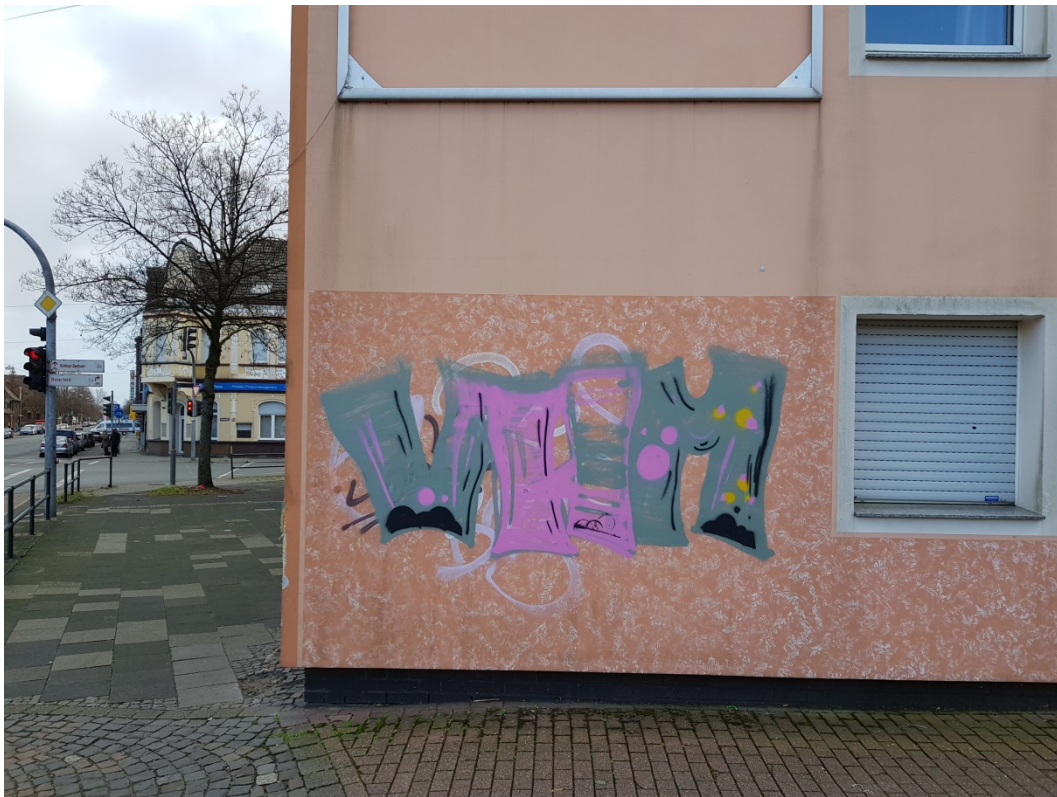
- Fassade Teutoburger Straße 220 -
