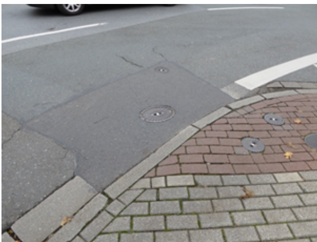
Abbildung 3: Pflasterschäden
