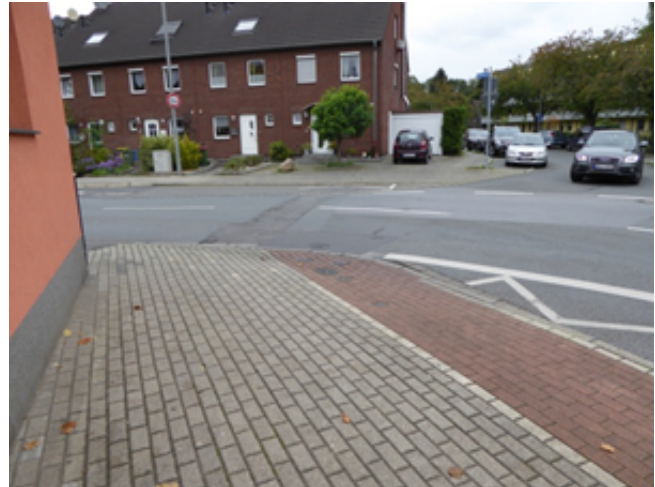
Abbildung 2: Engstelle im Einfahrbereich
