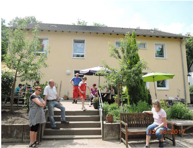
Ostansicht-Blick vom Außenbereich auf die Villa
