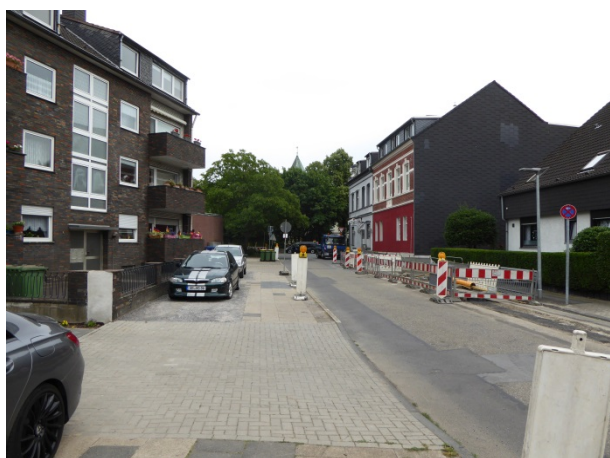
Abbildung 3: Baustellensituation und Gehwegparken
