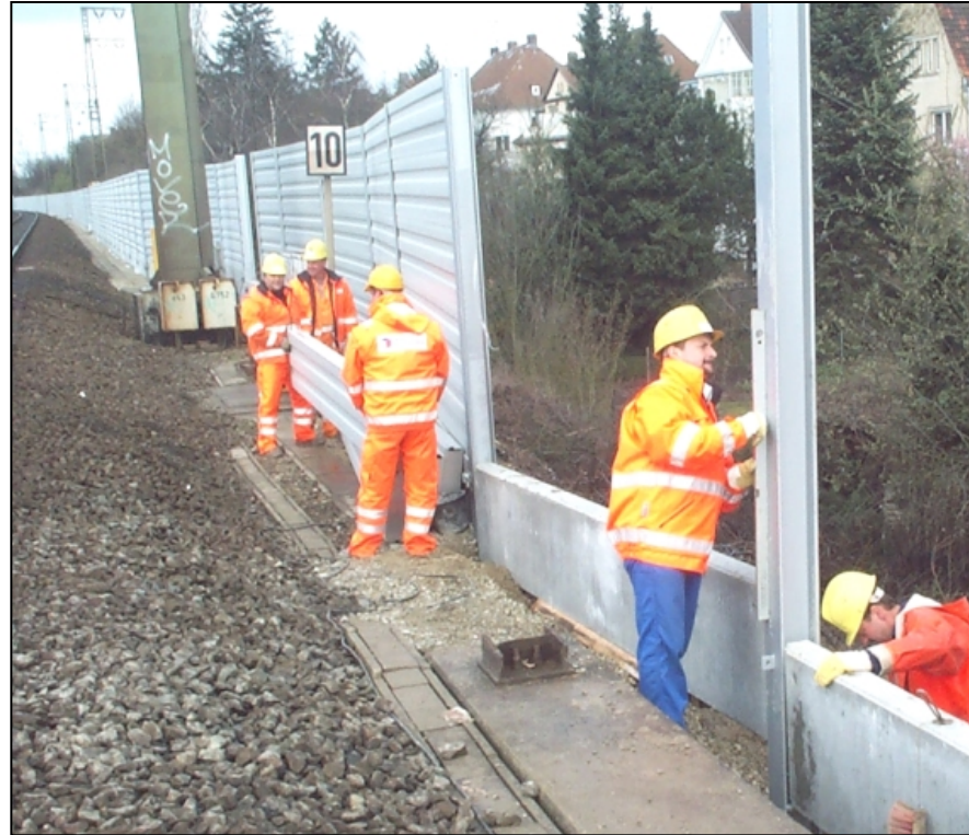
Bauen vom Gleis Einbau Betonsockel und Alu-Elemente, Einbau Randweg
