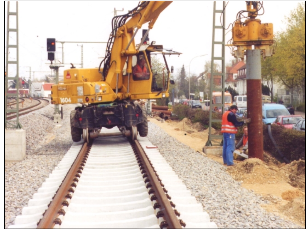
Bauen vom Gleis Einbringen der Rammrohre
