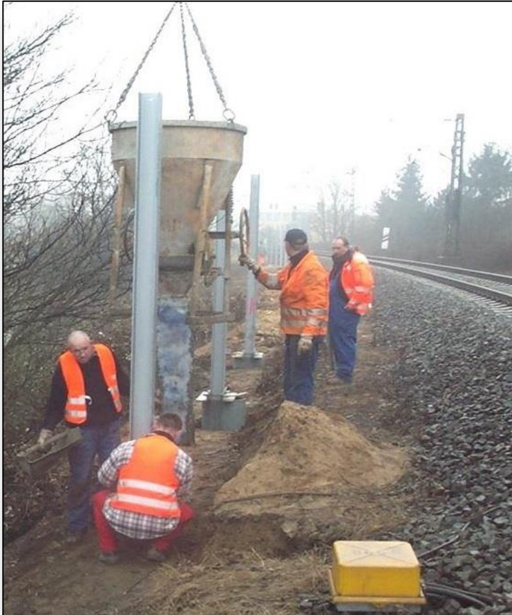
Bauen vom Gleis Setzen der Pfosten
