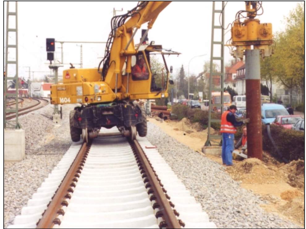
Bauen vom Gleis Einbringen der Rammrohre
