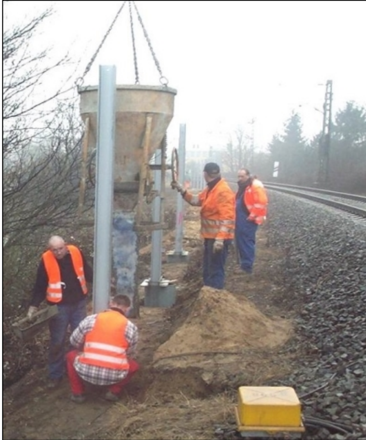
Bauen vom Gleis Setzen der Pfosten
