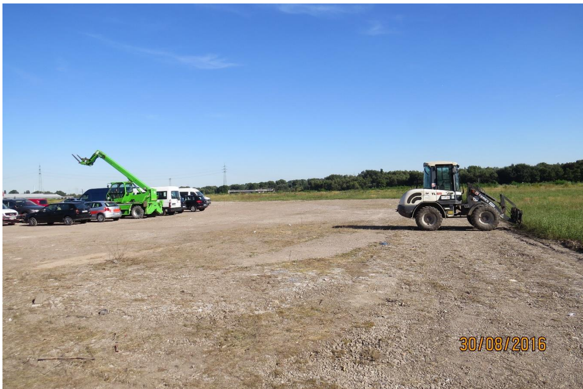
Foto 2: Teilfläche der Industriebrache, die 2016 als Stell- und Parkplatz für eine nördlich bestehende Baustelle diente.
