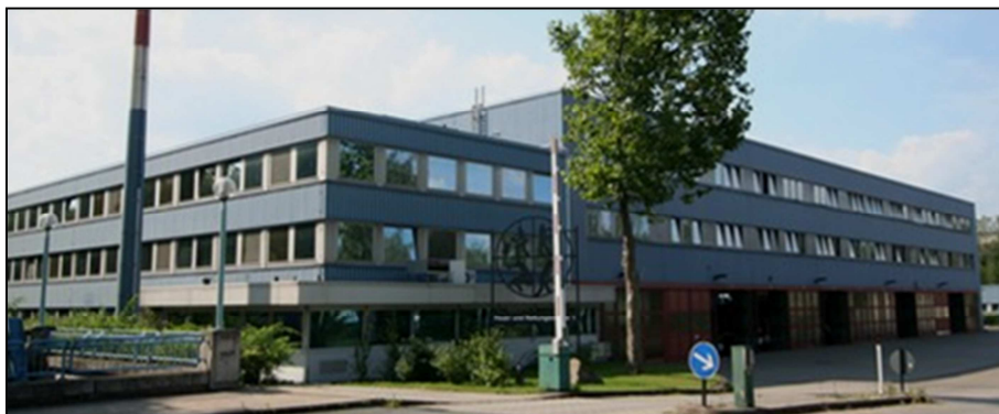
Abbildung: Feuer- und Rettungswache 1 (Brücktorstraße)
