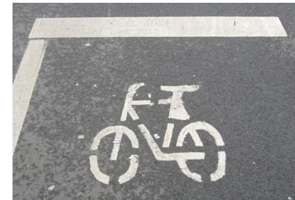
Abb. 7.8-3 Markierung eines Schutzstreifens in Sterkrade
