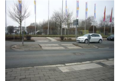
Nur eine Querungshilfe an der Holtener Straße
