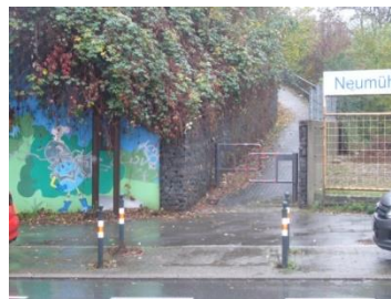
Bauliche Mängel reparieren
