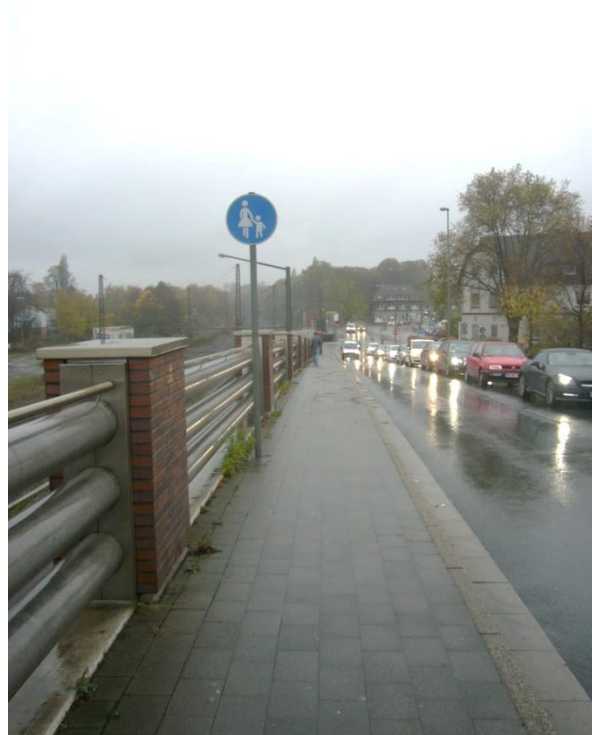
Abb. 7.3.1-1 Gehweg an der Ostrampe
