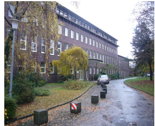
Abb. 7.1-6 Ist-Zustand MAN GHH Immobilien GmbH
