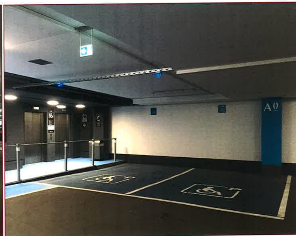
Behindertenparkplätze mit blauer Einzelstellplatzerkennung
