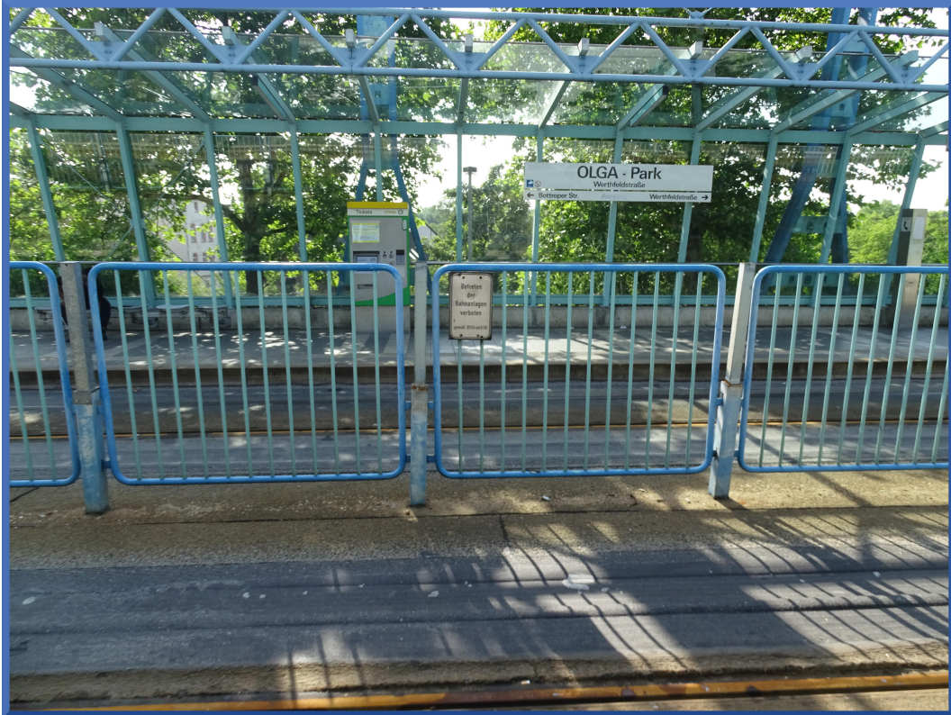
Bild 1: An der Haltestelle OLGA-Park verhindert ein hohes Gitter das eigentlich verbotene Überqueren der Trasse.
