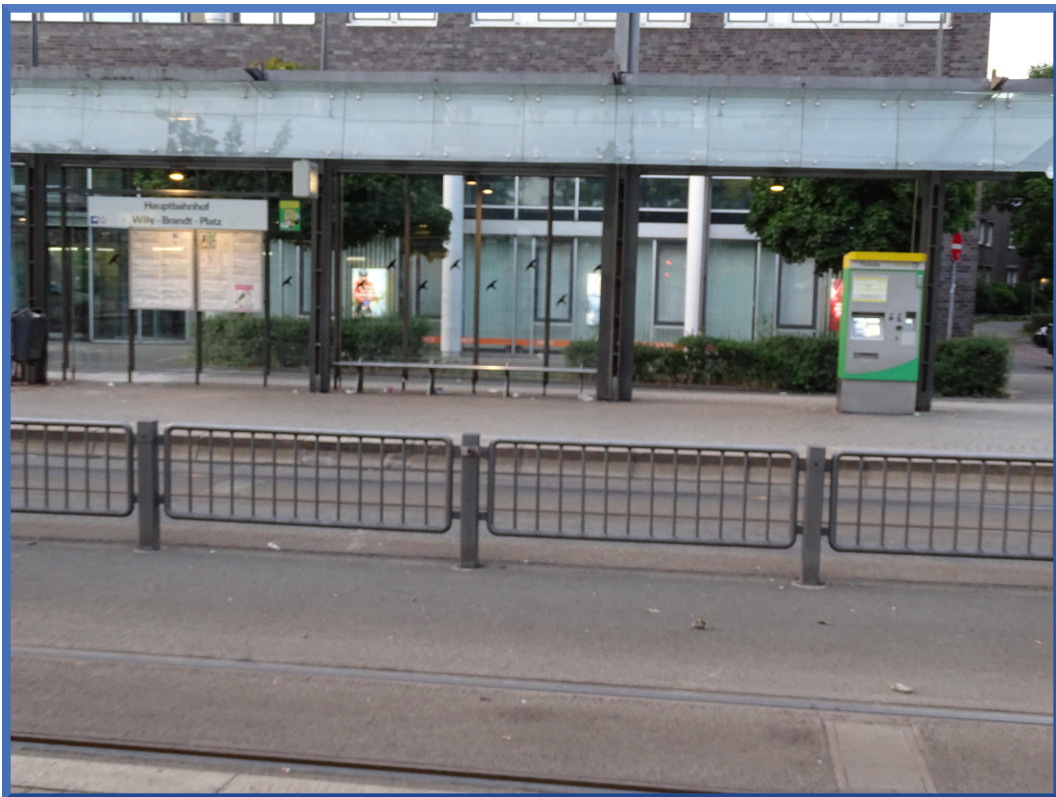
Bild 2: Hier ist das Gitter so niedrig, daß es nicht vom Überqueren der Trasse abhält.
