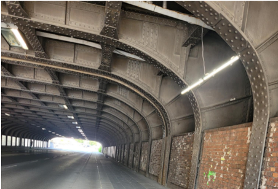
Abbildung 7: Testleuchte künstlerische Beleuchtung
