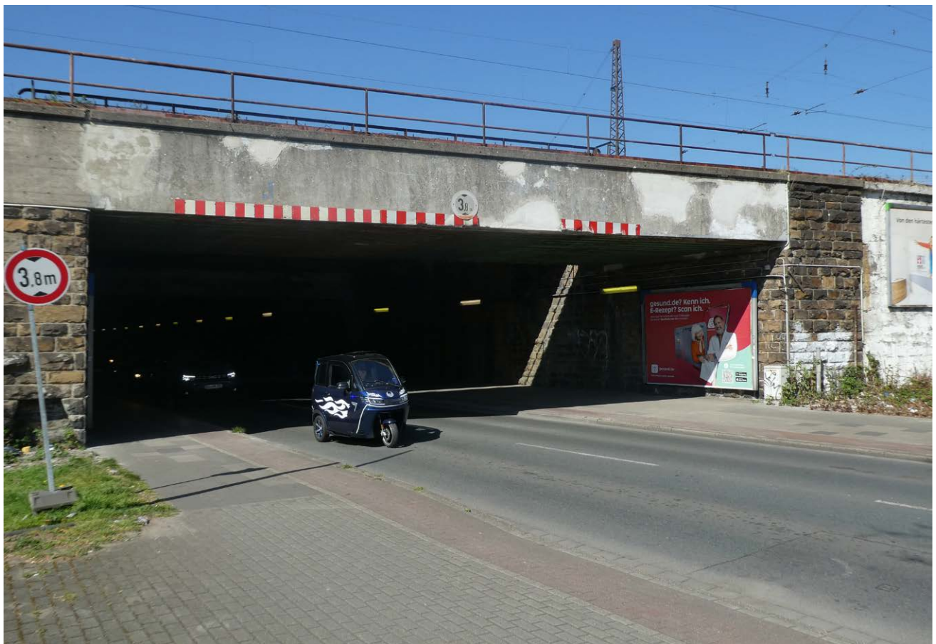
Unterführung Wilmsstraße, westliche Einfahrt
