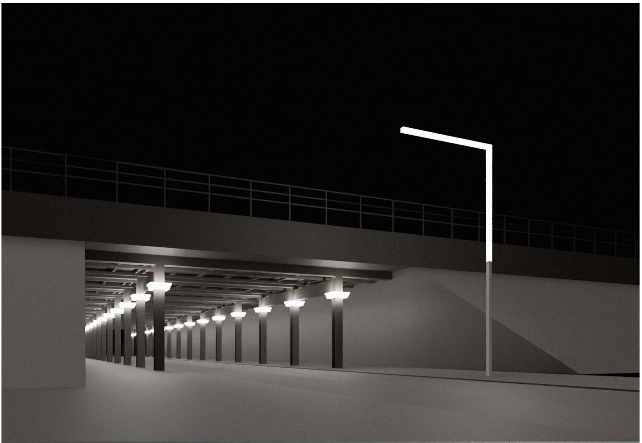
Unterführung Ruhrorter Straße nördliche Einfahrt
