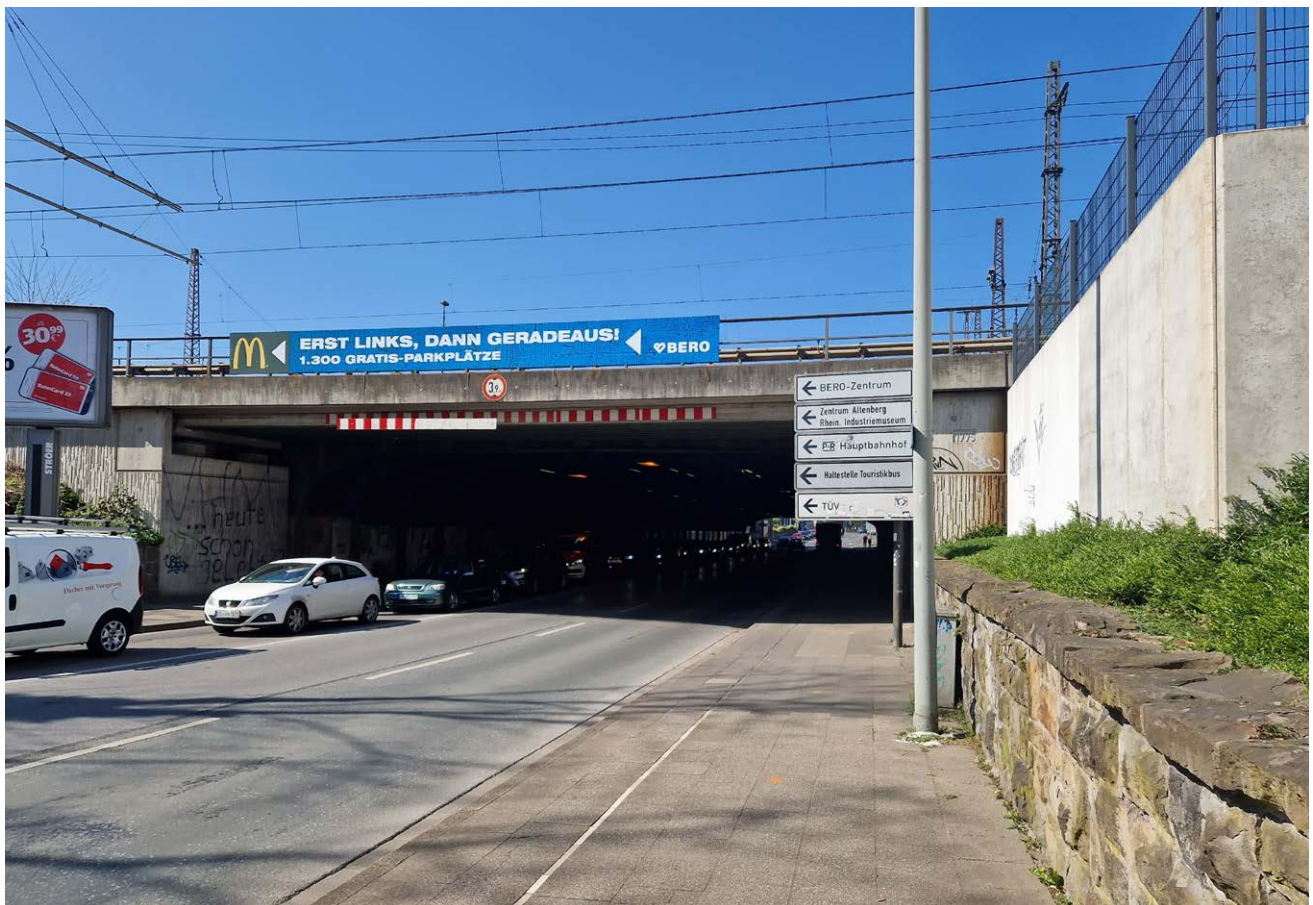
Unterführung Buschhausener-/Ebertstraße Östliche Einfahrt
