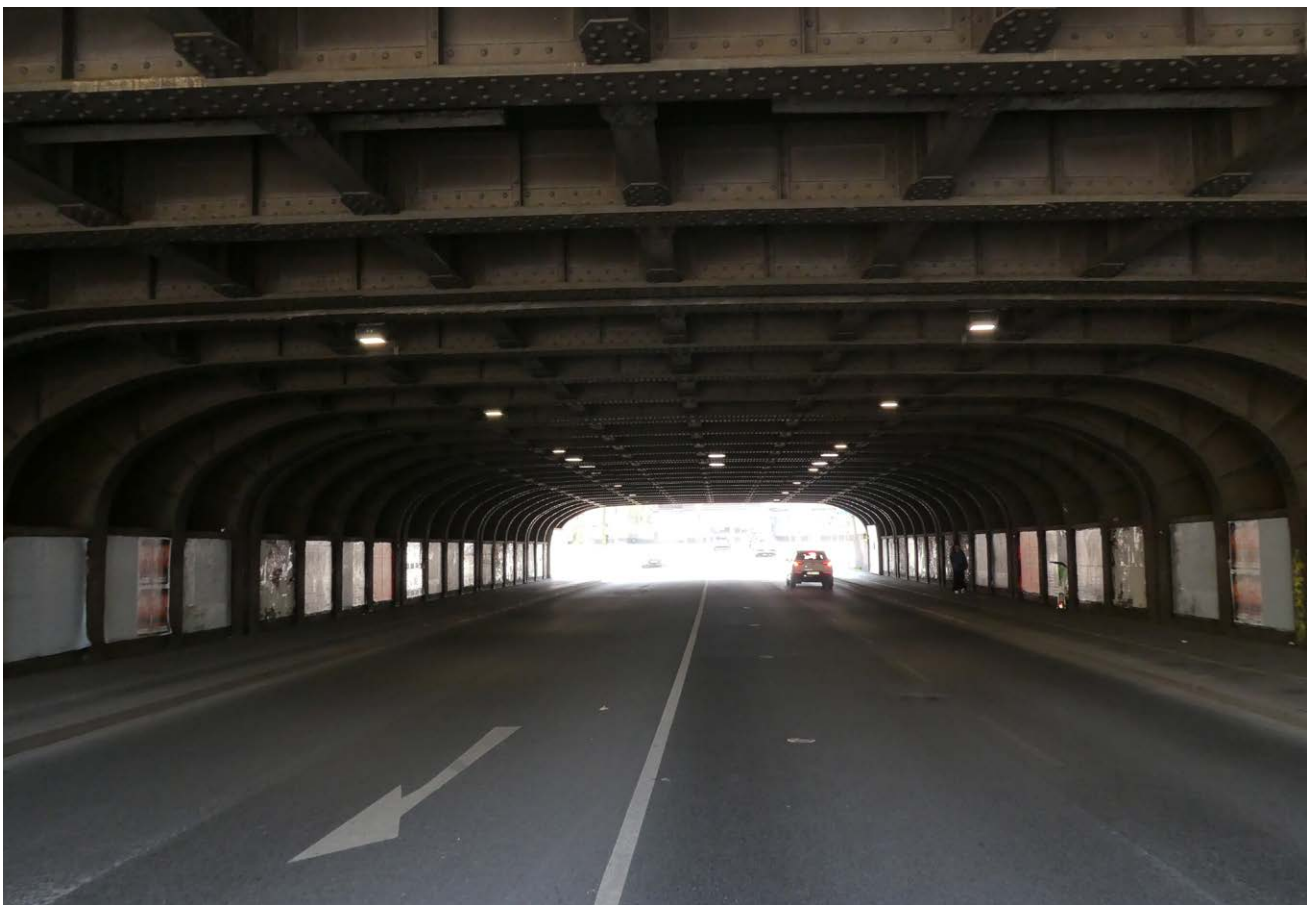
Unterführung Concordiastraße, nördliche Einfahrt
