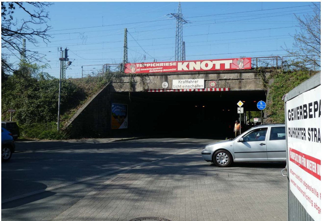
Unterführung Ruhrorter Straße Südliche Einfahrt
