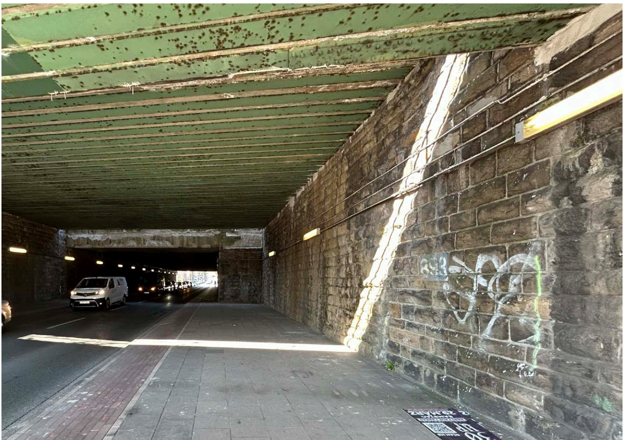
Unterführung Wilmsstraße, westliche Einfahrt
