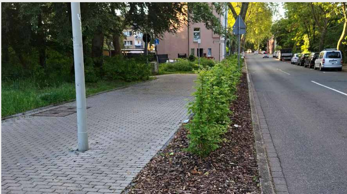
Abb. 10: Beispiel Straßenbegleitgrün und Versickerungspflaster – Stadt Oberhausen (2026)
