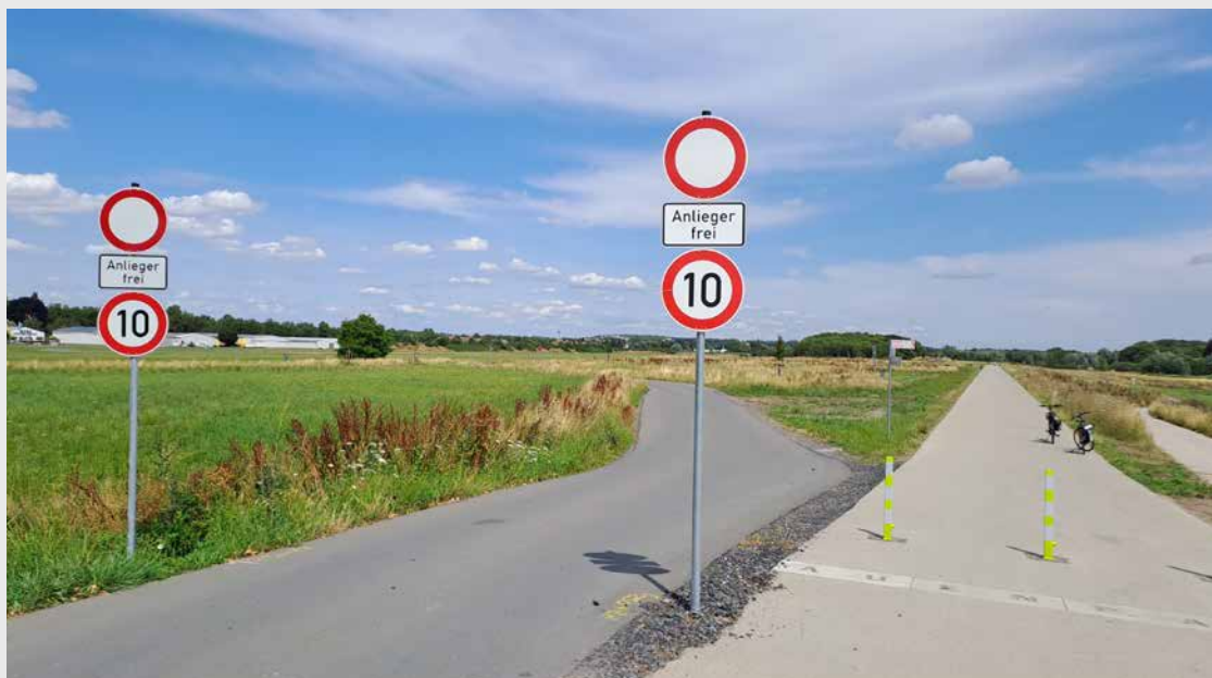
Abb. 13: Helle Gesteine und Farbasphalt – Stadt Hamm (2022)
