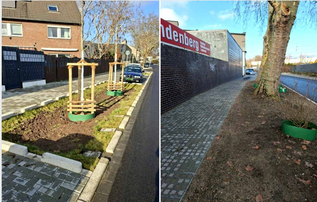
Abb. 20: links: Baumrigolen Hansastraße, rechts: Bestandsbäume mit Wurzelbrücken-Pflaster (Stadt Oberhausen, 2026)
