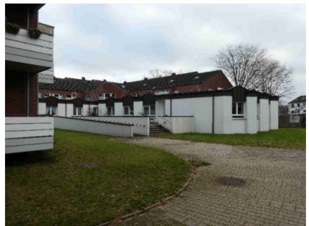
Foto 30: Wohngebäude und Erschließung im Westen
