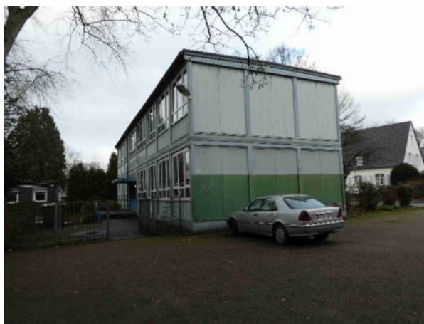
Foto 3: Flachdach mit außenliegender Entwässerung
