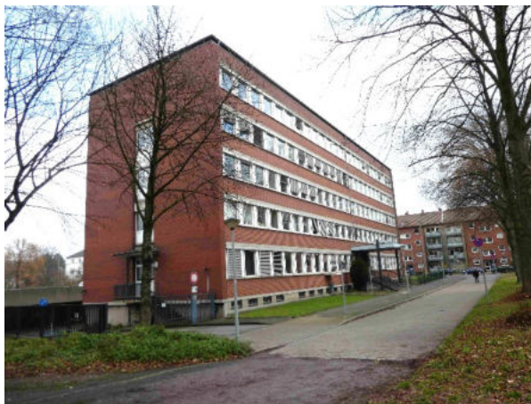
Foto 51: Flachdach mit außenliegender Entwässerung
