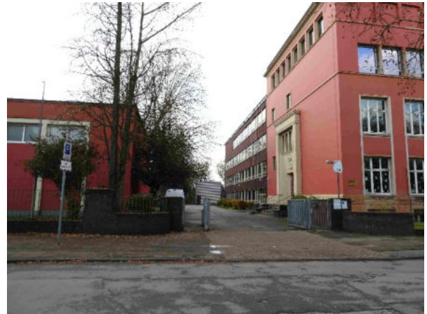
Foto 22: Sporthalle (Süden) und Zugang zum Schulhof von der Wilhelmstraße
