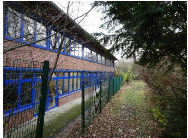
Foto 14: Schulgebäude Ostansicht mit Fallrohren (daran angrenzende Freifläche)
