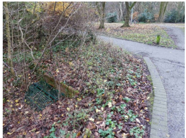
Foto 12: mündet in Verrohrung (Weiterführung unklar)
