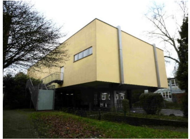
Foto 6: Eingangsgebäude im Süden mit tieferliegender Schulhofffläche
