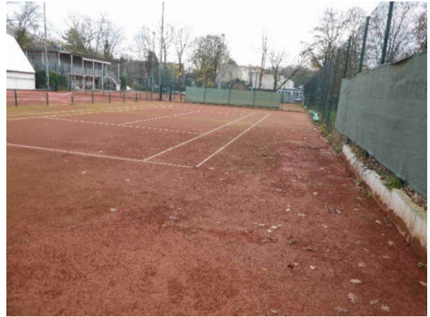
Foto 49: Ascheplatz im Westen (Entwässerung in Richtung Kastenrinne?)
