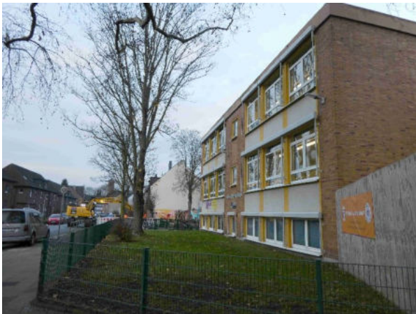
Foto 68: Schulgebäude mit Flachdach
