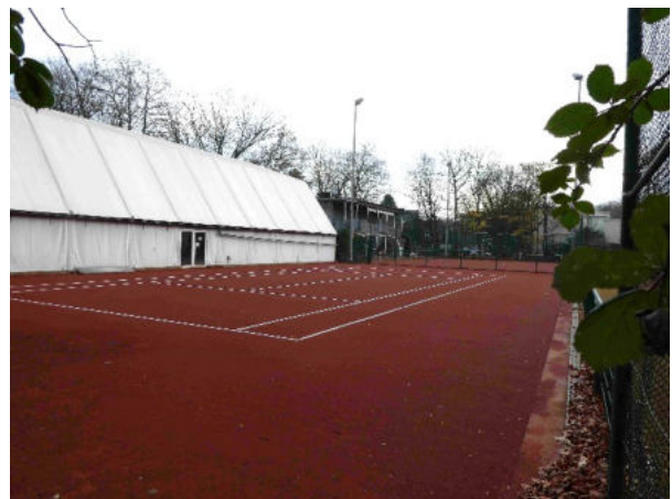
Foto 47: Ascheplatz mit Entwässerungsrinne und Zelthalle mit außenliegender Entwässerung
