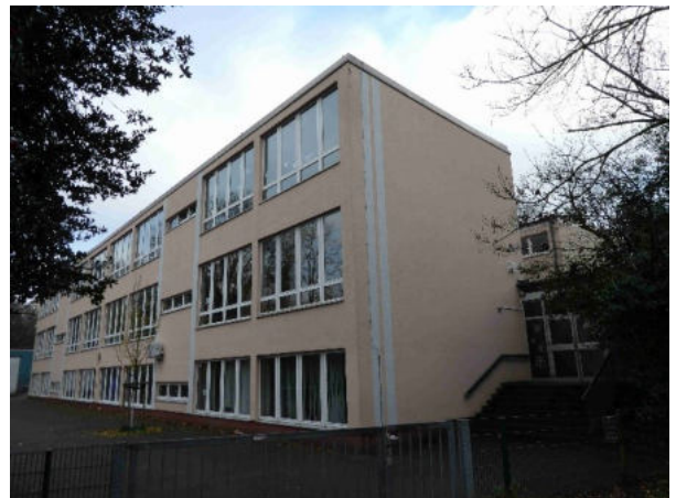
Foto 8: Flachdach mit innenliegender Entwässerung (westliches Schulgebäude)
