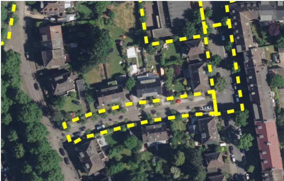
Abbildung 45: Luftbild TF 4.14 (Straßenfläche „Im Kreuzfeld“)
