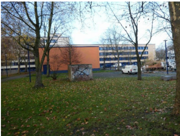
Foto 95: Kolleg von Osten mit Schulhof
