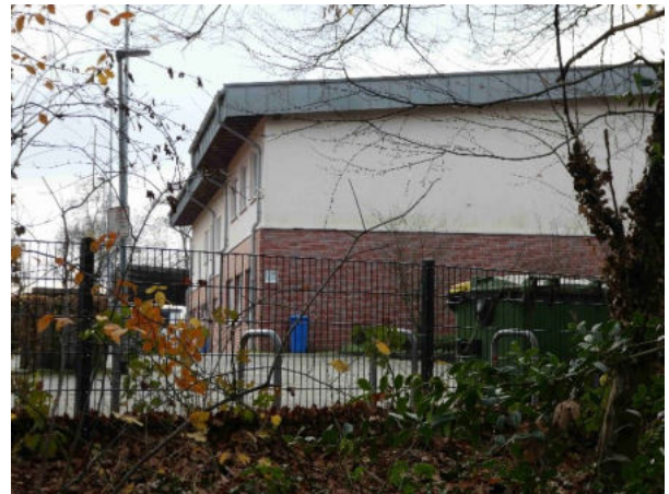
Foto 54: Pultdach mit außenliegender Entwässerung nach Osten
