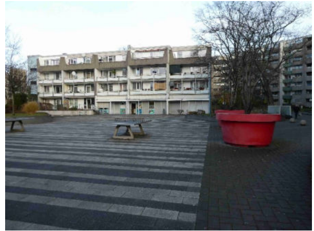
Foto 92: zentraler Hofplatz (im Untergrund Tiefgarage)
