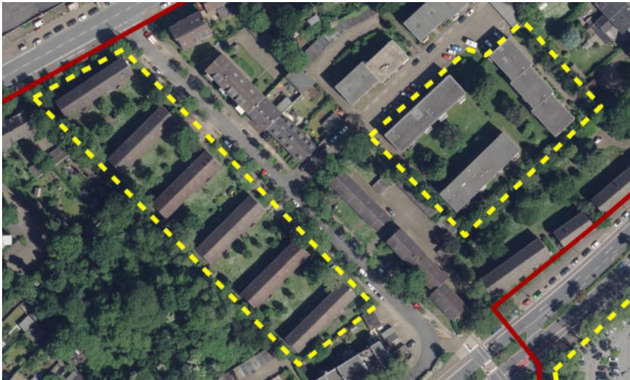
Abbildung 79: Luftbild TF 11.29 (Gebäude Von-Stephan-Straße)
