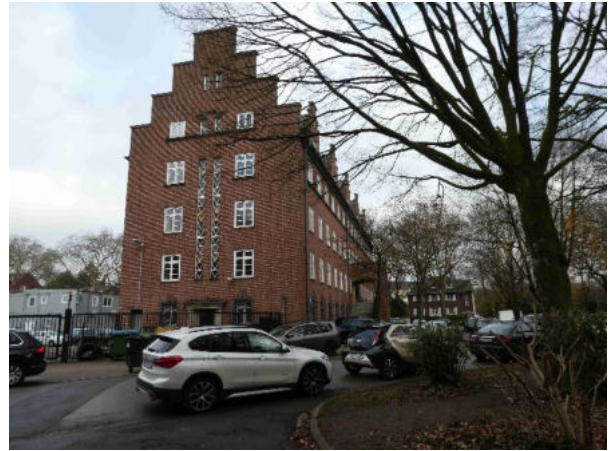
Foto 60: mit außenliegender Entwässerung
