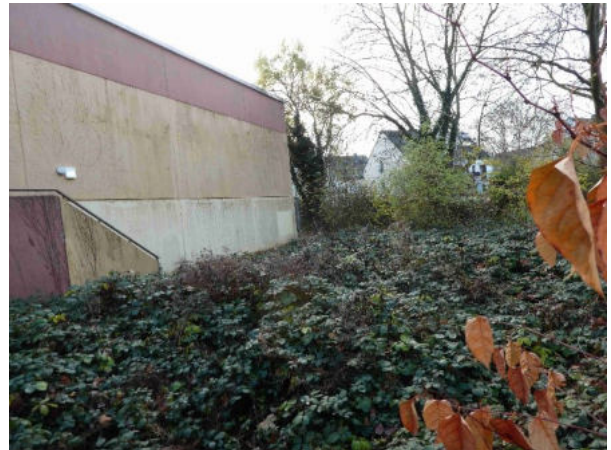
Foto 73: ungenutzte Freiflächen im Westen
