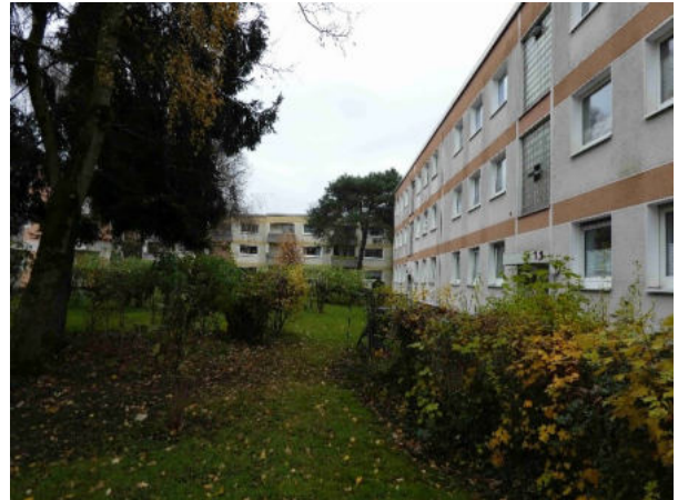
Foto 108: Freiflächen im Innenbereich der drei Gebäudekomplexe
