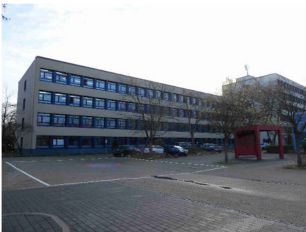
Foto 97: Schulgebäude von Osten
