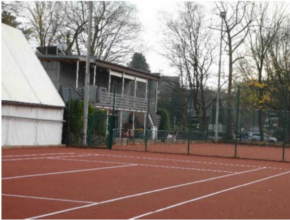
Foto 48: festes Gebäude und Zelthalle mit außenliegender Entwässerung
