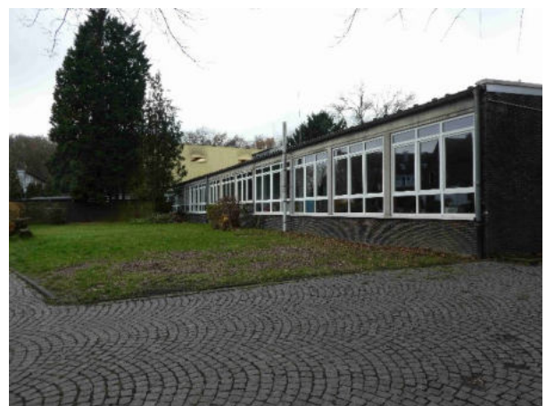
Foto 4: Flachdach mit außenliegender Entwässerung
