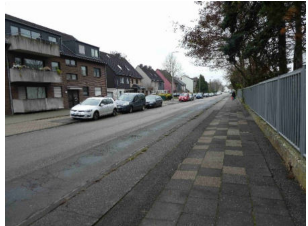
Foto 100: Alleestraße mit breiten Straßenraum und ohne Straßenbäume
