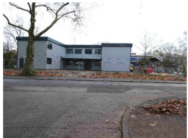
Foto 16: neues Schulgebäude am Gymnasialplatz/Wilhelmstraße
