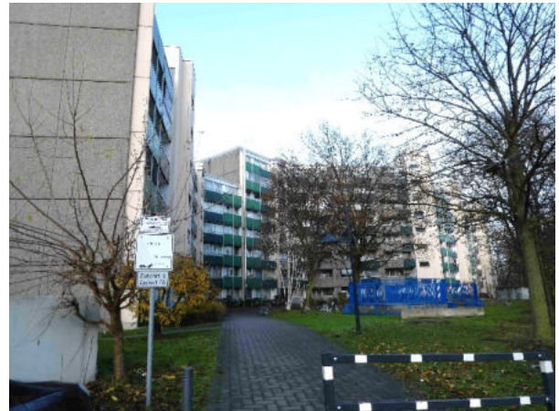
Foto 94: mehrgeschossige Wohnbebauung mit Erschließung
