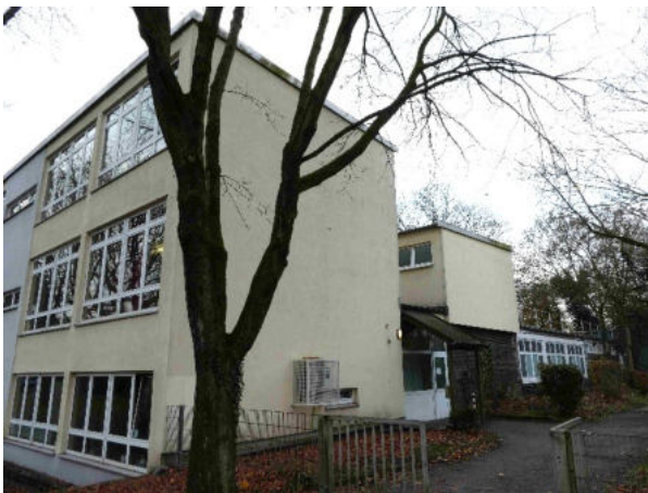
Foto 9: höhere Gebäude mit Flachdach und innenliegender Entwässerung, niedrigere Gebäude mit Flachdach und außenliegender Entwässerung (nördliche Schulgebäude)
