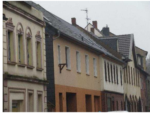
13. Kastellstraße, Blick nach Westen, 2018
