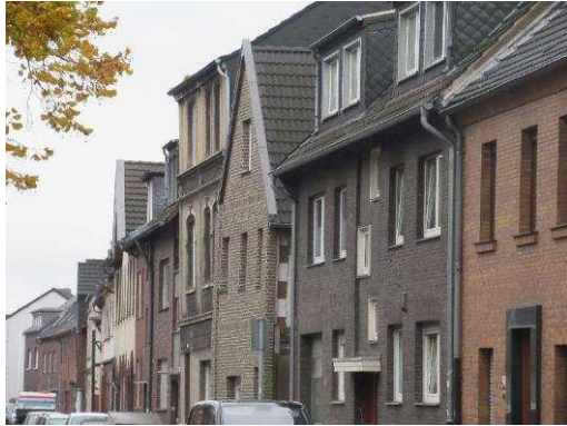
12. Kastellstraße, Blick nach Osten, 2017
