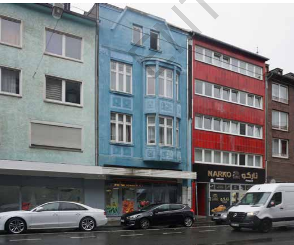
Abb. 30: Fassaden in störenden, ortsuntypischen Farben
