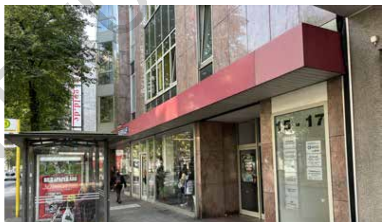
hohes kastenförmiges Vordach
