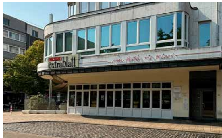
architektonisch integriertes Vordach
