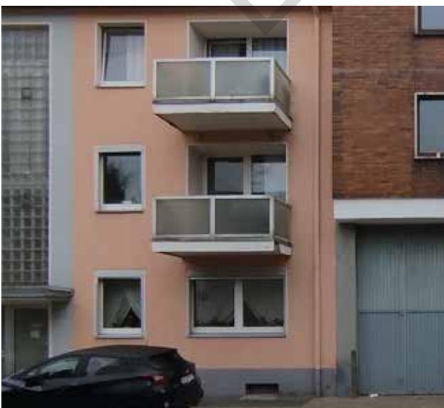
tief auskragende Balkone
