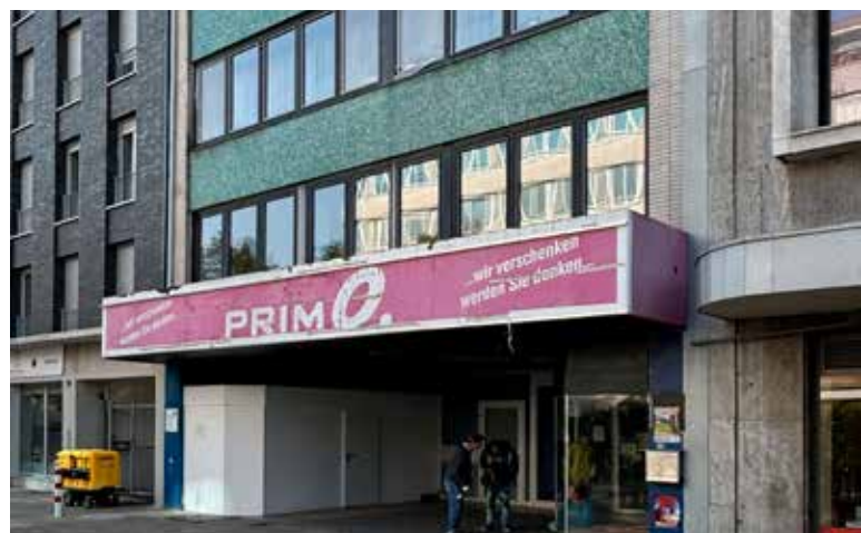
hohes kastenförmiges Vordach
