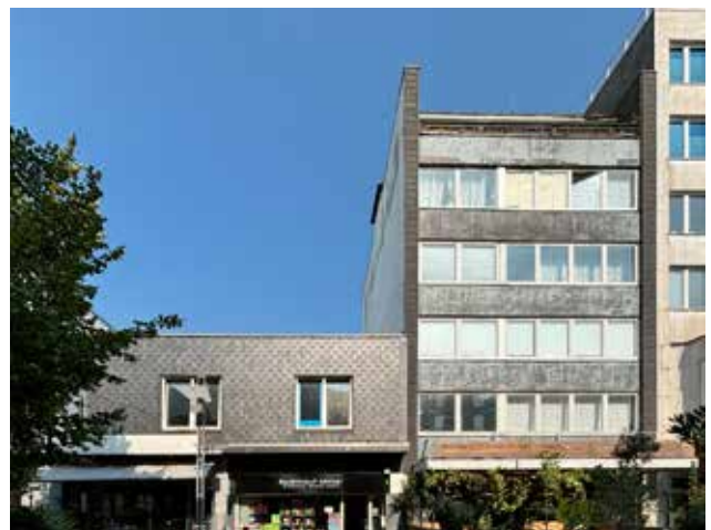
störender Höhenversprung (fehlender OG-Wiederaufbau)
