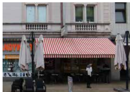
zu tief auskragend und zu breit
