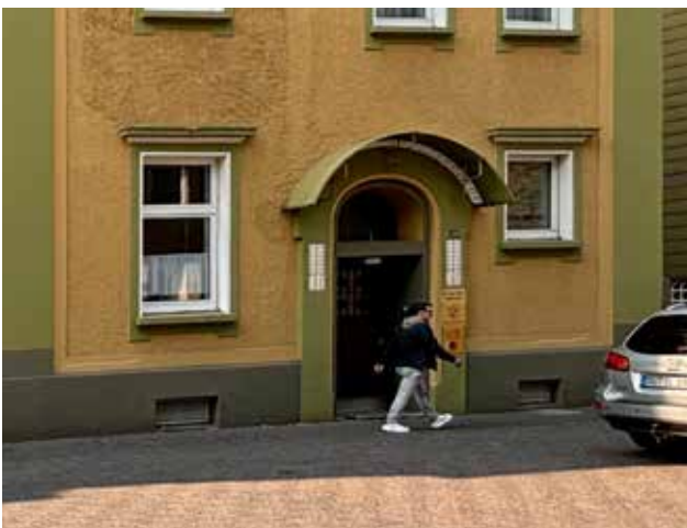
öffnungsbezogenes Vordach an Gründerzeitgebäude
