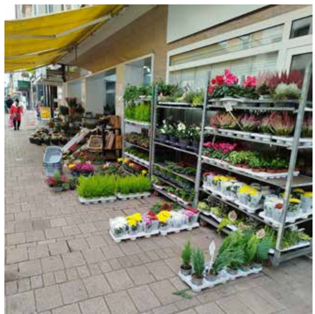
Verstellung der Fassade durch Warenregale
