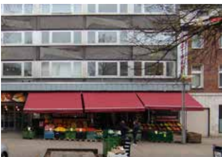
zu tief auskragend und zu breit
