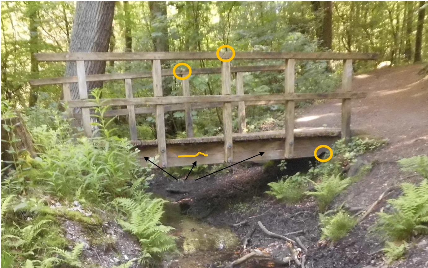
Abbildung 3 Brücke am Handbach (Foto vom Ortstermin am 14.05.2024)
