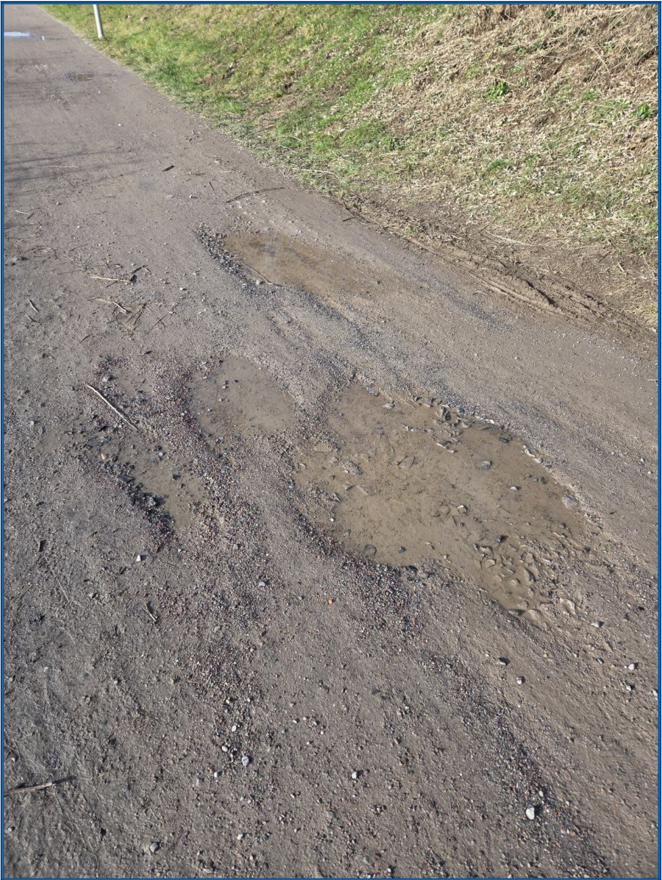
Bild 2: Detailansicht der Fahrbahndecke in einem typischen Zustand.
