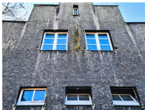
Westfriedhof einschl. Jüdischer Friedhof, Südliches Wohngebäude, Ostgiebel mit bauzeitlichen Fenstern. Foto: Stadt Oberhausen.
