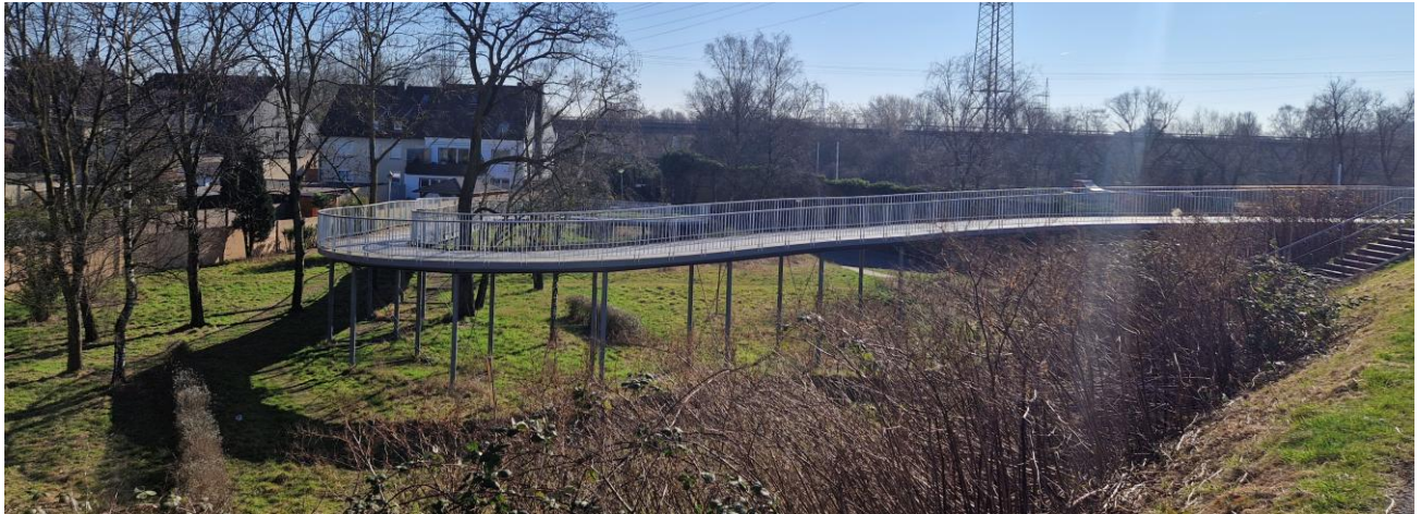
Abb. 12: Rampe zur Emscher-Brücke [Foto: nts]
