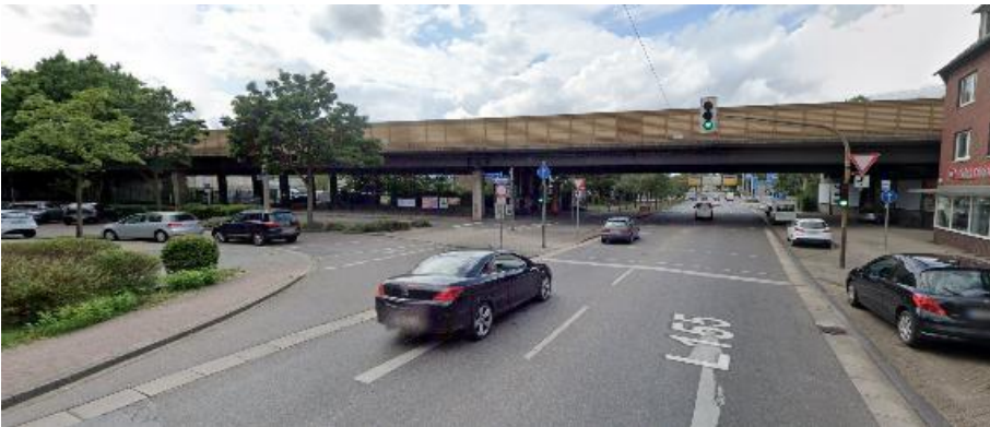
Brückenansicht von der „L155 Teutoburger Straße“ Quelle: Google Maps
