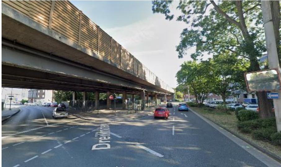
Brückenansicht von der Straße „Dreilinden“ Quelle: Google Maps
