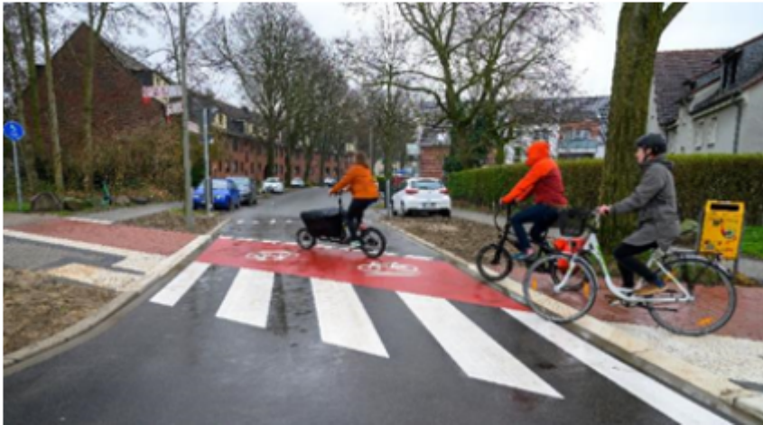
Abbildung 3: Umgesetzte Querung an der Michelstraße (Quelle: Stadt Oberhausen/Tom Thöne)
